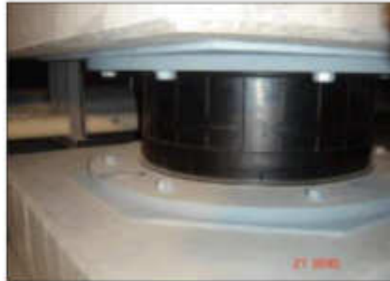
Figura 5. Aislador de caucho natural
