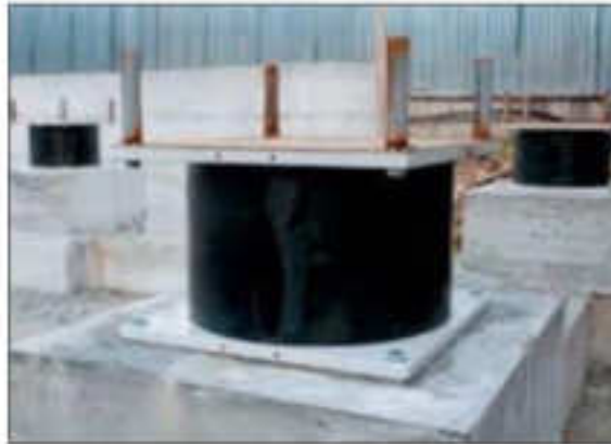
Figura 6. Aislador elastomérico
