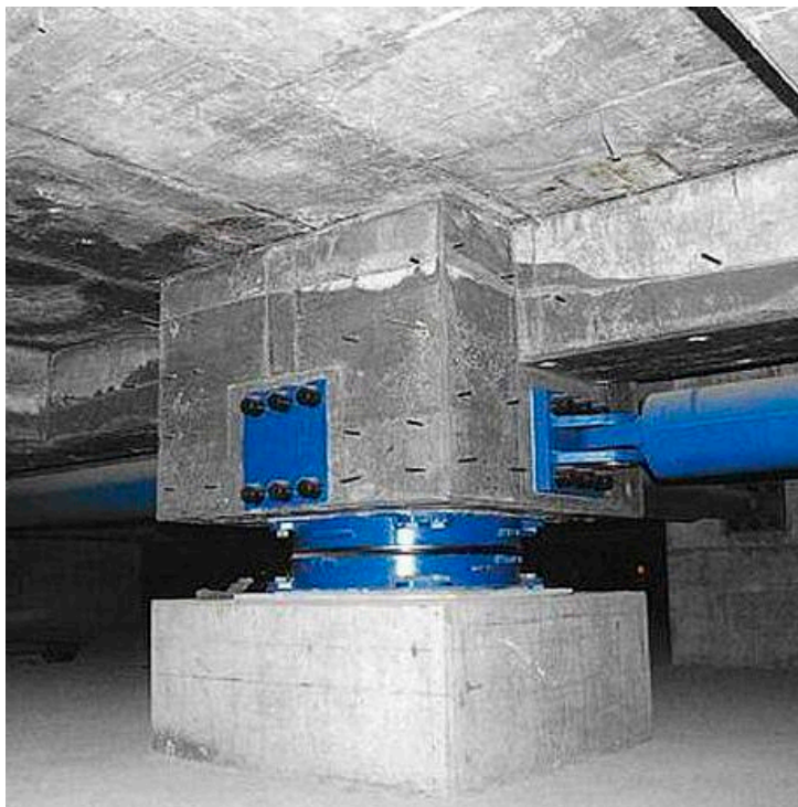
Figura 14. Aislador sísmico corredizo (Fuente: http://www.archiexpo.es/prod/maurerse/product-126637-1907631.html ). La rótula se mueve entre dos placas de apoyo cóncavas y simétricas, duplicándose la capacidad de desplazamiento en comparación a los péndulos de aislamiento deslizantes simples.
