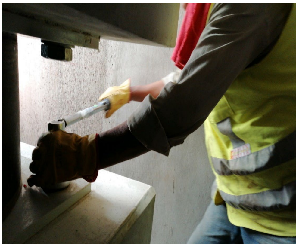
Foto 39. Ajuste de los pernos en forma secuencial con uso del torquímetro (Fuente: Consorcio Hospital Tacna - Hospital Hipólito Unanue de Tacna, 2018).
