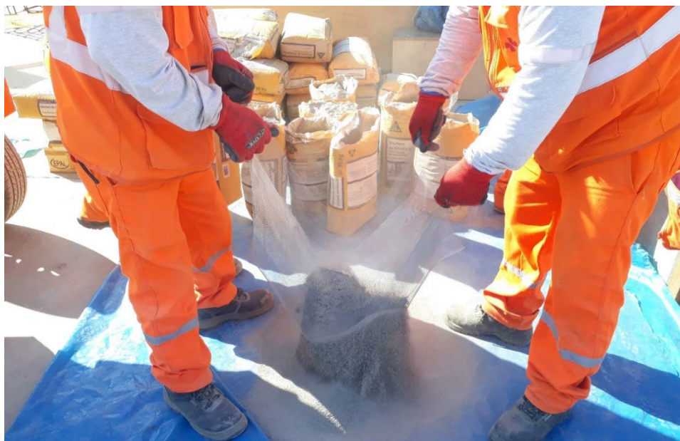
Foto 34. Zarandeo del material para el preparado del grout (Fuente: Consorcio Hospital Tacna - Hospital Hipólito Unanue de Tacna, 2018).
