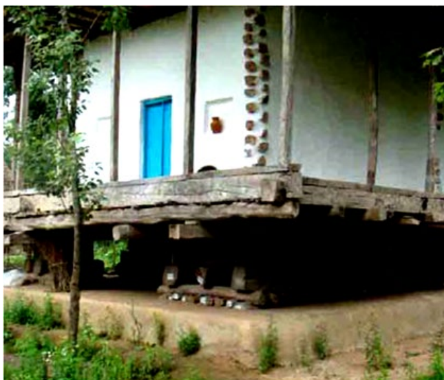
Figura 9. Vivienda en la zona del mar Caspio (Fuente: Geniatus & Lafuente, 2016). El uso de fundaciones de madera es otra manera tradicional de generar aislamiento sísmico.
