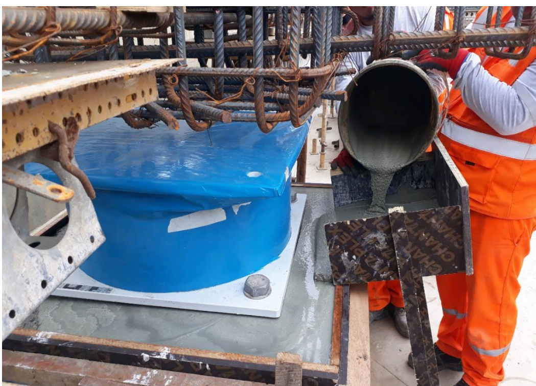
Foto 37. Colocación del grout sobre el pedestal (Fuente: Consorcio Hospital Tacna - Hospital Hipólito Unanue de Tacna, 2018).
