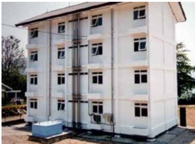
Figura 15. Edificación en Java, Indonesia, construida con el plano de aislamiento sobre el terreno. (Fuente: Geniatus & Lafuente, 2016). Se observa el caso de una edificación que fue colocada sobre aisladores sin restricciones y a un nivel externo, de piso, lo cual presente una excelente y económica solución.
