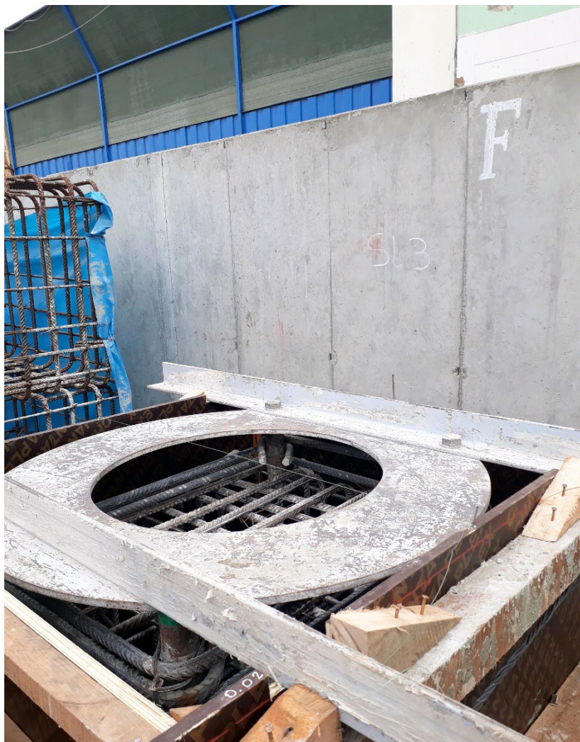
Foto 31. Ensamblaje final sobre pedestal armado. (Fuente: Consorcio Hospital Tacna - Hospital Hipólito Unanue de Tacna, 2018)
