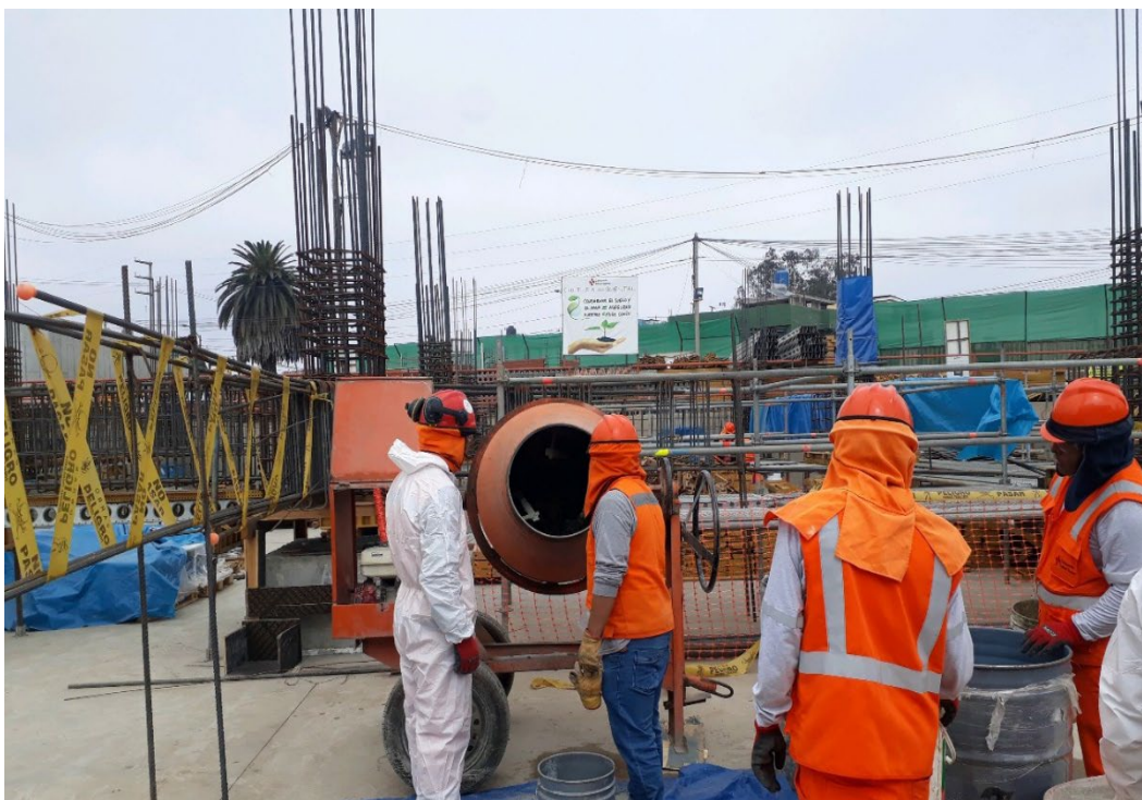
Foto 36. Preparación del grout en la máquina mezcladora (Fuente: Consorcio Hospital Tacna - Hospital Hipólito Unanue de Tacna, 2018).
