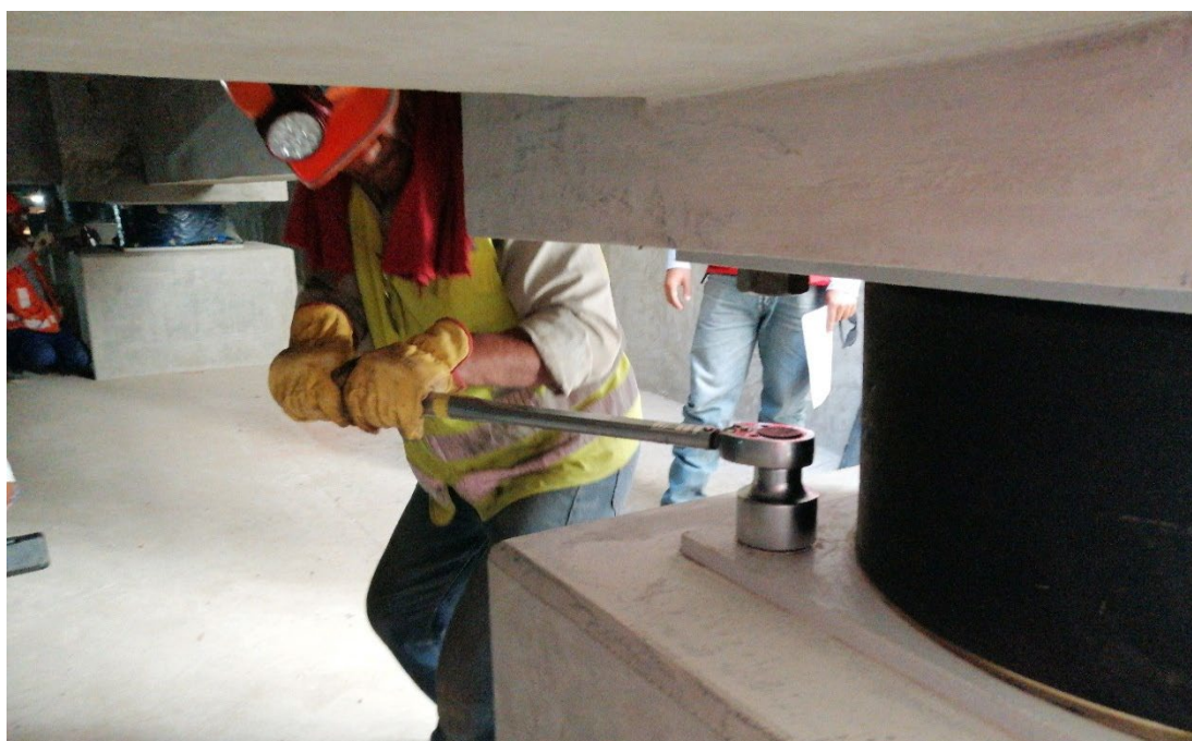
Foto 41. Aplicación del torque – pernos inferiores. (Fuente: Consorcio Hospital Tacna - Hospital Hipólito Unanue de Tacna, 2018).
