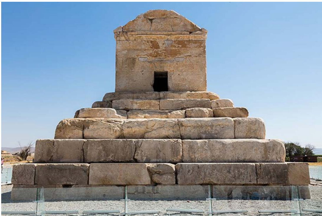
Figura 8. Tumba de Ciro Grande (Fuente: Geniatus & Lafuente, 2016). La tumba de Ciro Grande fue construida en el año 550 A.C en Pasargadae, Persia. Se observa el uso de piedras cortadas, alisadas y colocadas en varias capas sin mortero.
