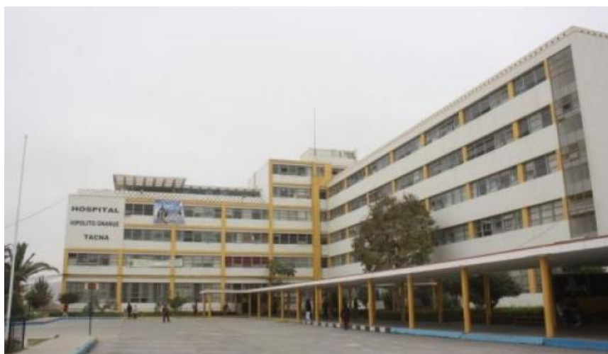
Figura 1. Vista del Hospital Hipólito Unanue de Tacna, antes de su demolición (Fuente: https://gestion.pe/economia/empresas/assignia-adjudica-cuatro-obras-peru-us-157-millones-107933 ).
