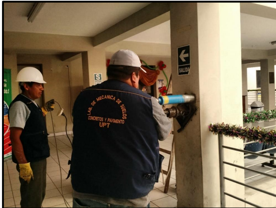
Imagen 08 Perforación en columna 03 con equipo de diamantina
