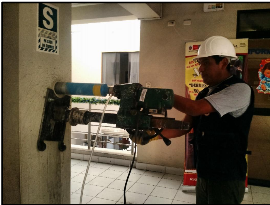
Imagen 07 Perforación en columna 02 con equipo de diamantina
