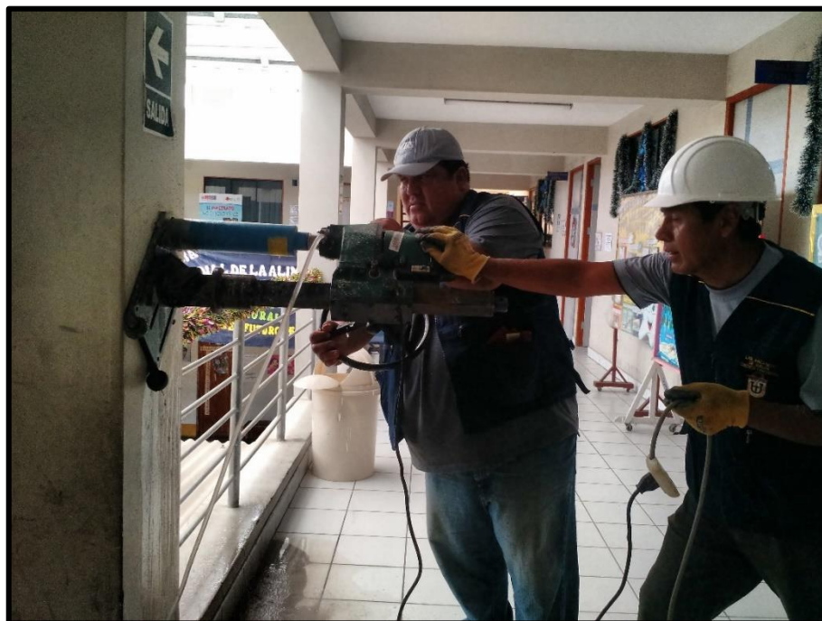
Imagen 09 Perforación en columna 03 con equipo de diamantina
