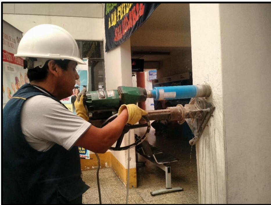
Imagen 03 Ensayo de Diamantina columna 01
