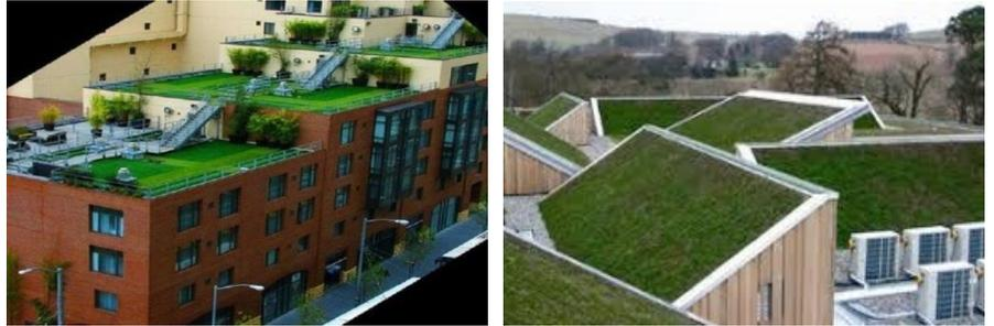
**Funcionamiento de un Techo Verde:** Un techo verde funciona como un micro habitat en las azoteas y techos de edificios. Funcionan también técnicamente para evitar daños al edificio que los soporta. En la estructura de un techo verde, existen principalmente 6 capas que lo componen:
