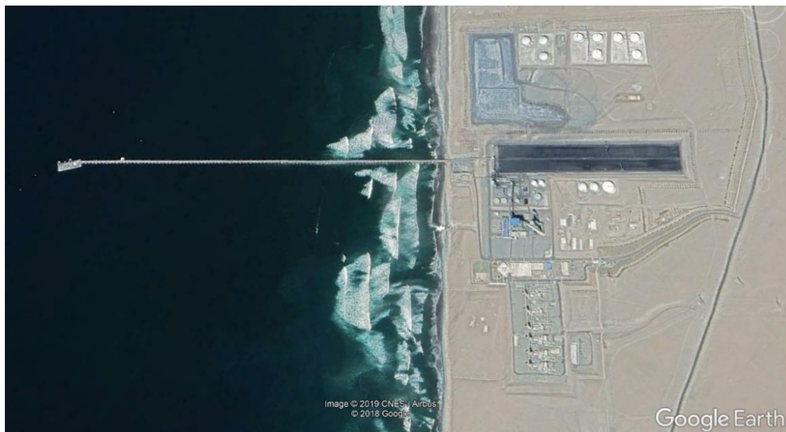
Figura 2: Central termoelectrica ilo 21, muelle de la planta, se aprecia la ceniza volante compactada almacenada.
