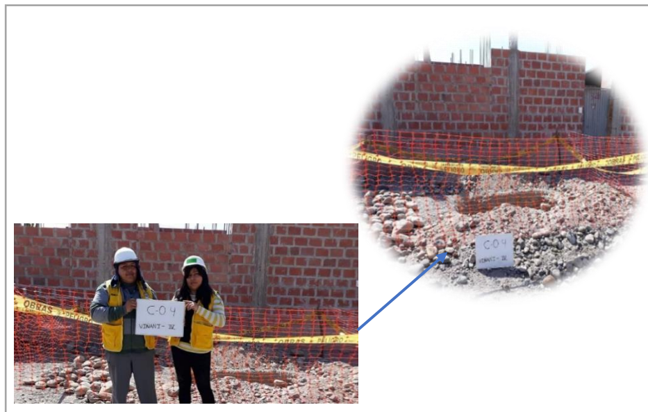
Figura 29. Implementos de seguridad en la excavación de las calicatas.
