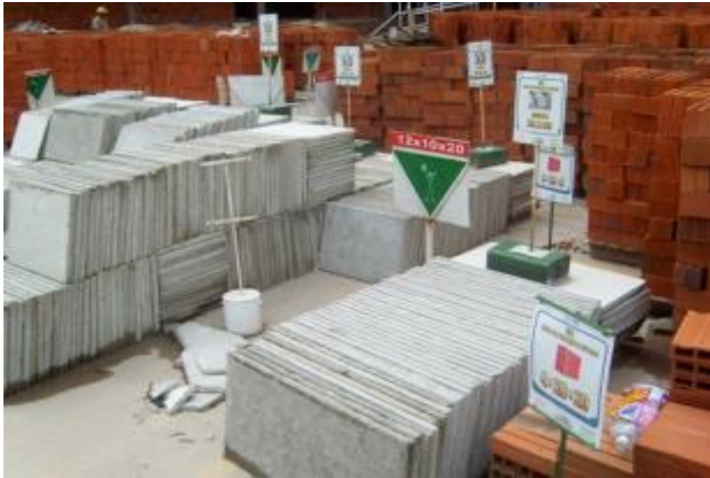
Figura 4. Organización de obras de construcción basadas en la gestión visual y 5S
