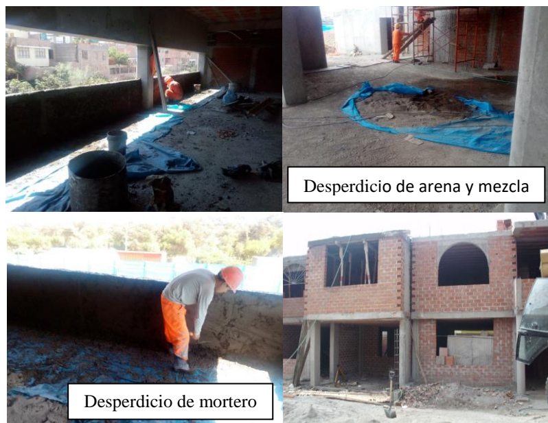
Figura 1: Desperdicios de materiales en la construcción de edificaciones
