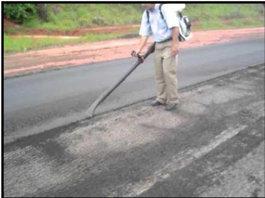
**FIGURA 22: LIMPIEZA DEL PAVIMENTO ASFÁLTICO
