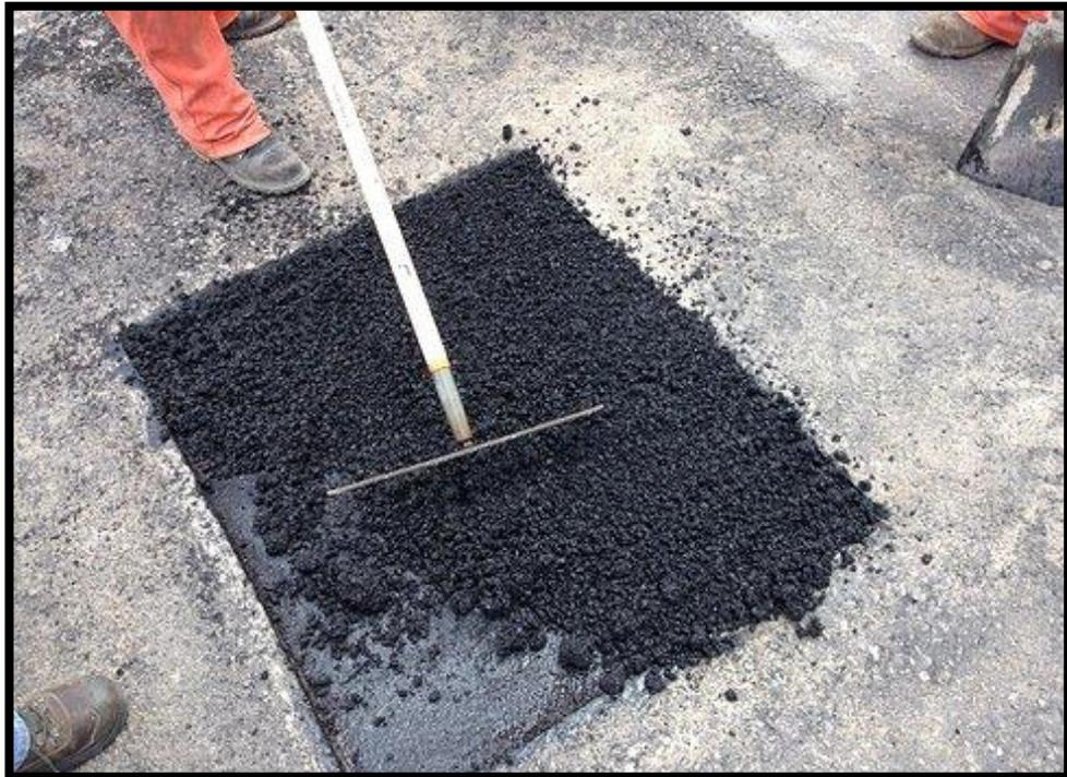
**FIGURA 20: TRABAJO PREVIO: RELLENO DE ZONAS DAÑADAS CON PIEDRA TRITURADA, MEZCLA EN FIO O EN CALIENTE**
