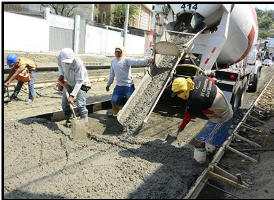
**FIGURA 24: COLOCADO DEL CONCRETO**
