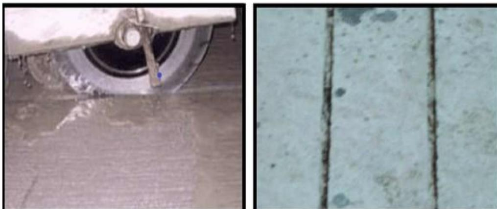
**FIGURA 27: ASERRADO DE JUNTAS**
