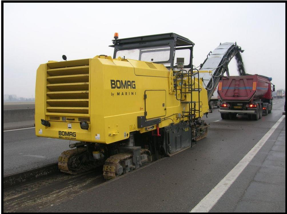
**FIGURA 21: FRESADO EN SECO DEL PAVIMENTO ASFÁLTICO**
