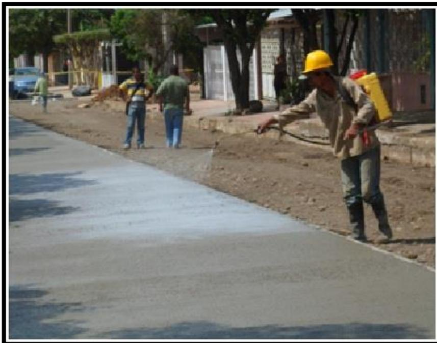
**FIGURA 26: CURADO DEL CONCRETO**
