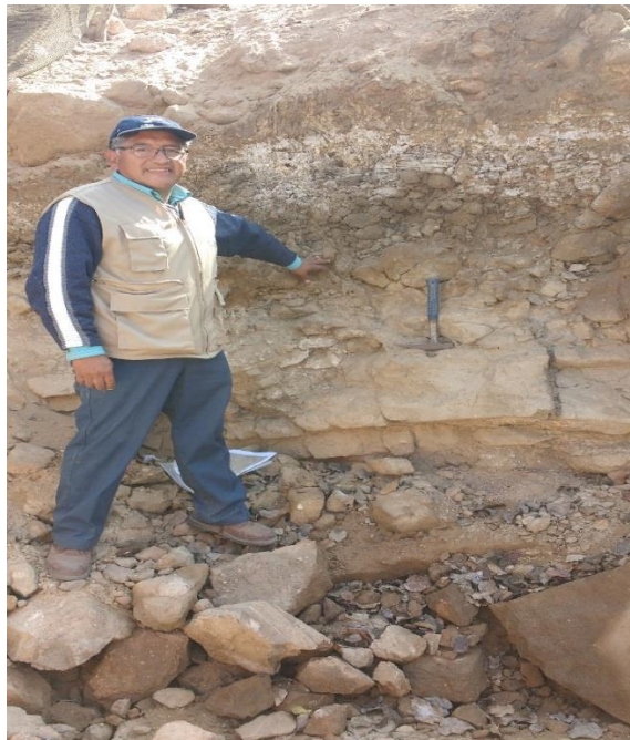
Figura 32: Areniscas tobáceas de la formación Huaylillas muy fracturadas a extremadamente fracturadas.
