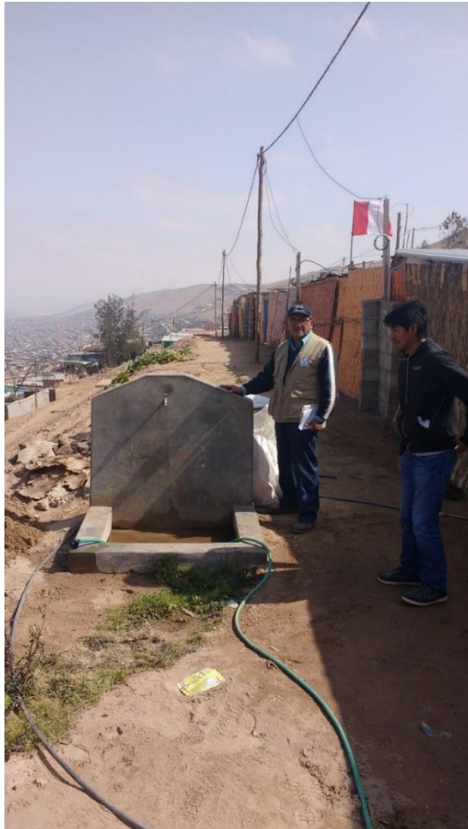
Figura 34: Terraza Tecnógena, construida con material propio proveniente de la excavación de la ladera.
