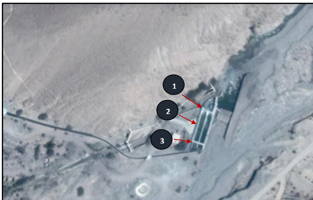
Figura N°15: Ubicación de obtención de muestras de ensayo perforación con broca diamantada.
