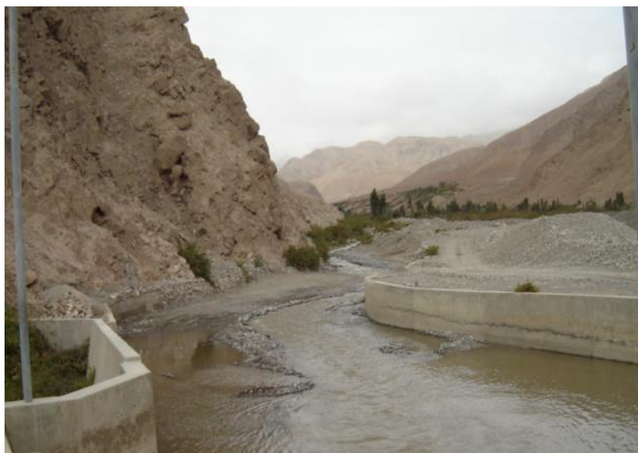
Figura N° 01: Captación del río Uchusuma, Muros de encauzamiento.
