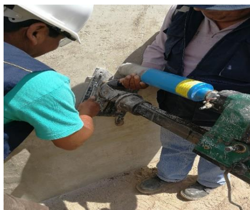
Figura N° 18: Colocación de equipo de Diamantina.
