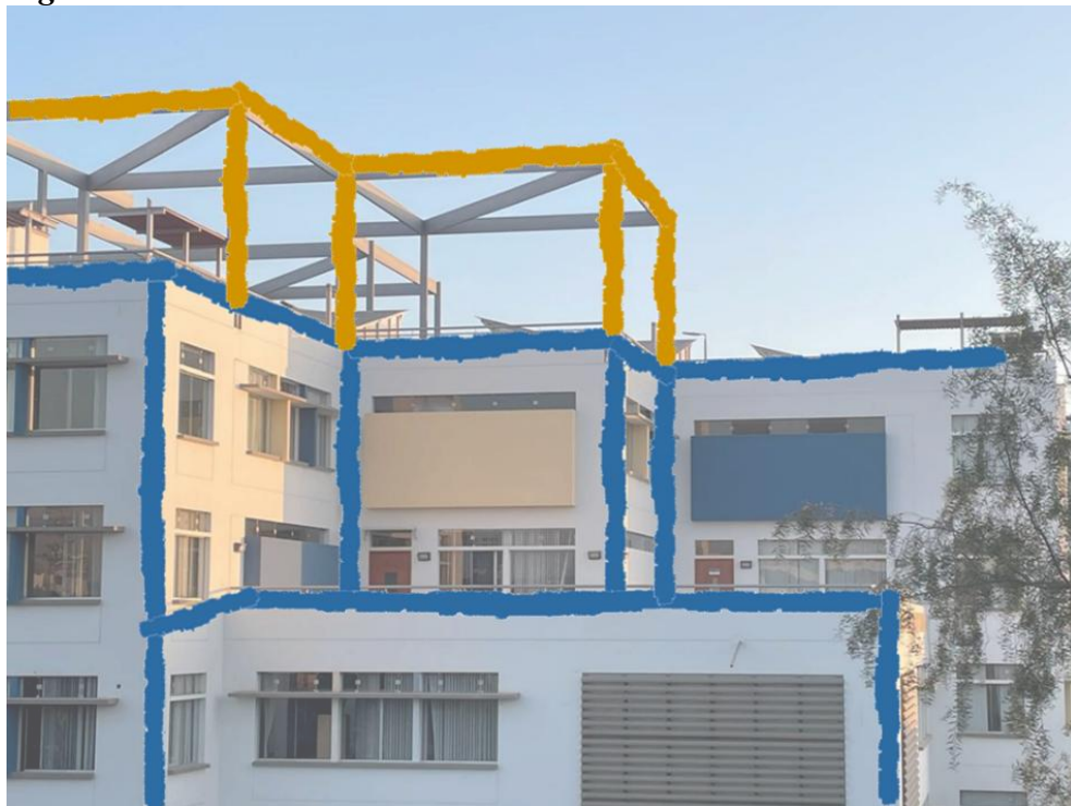
Figura 31. Abstracción de la estructura metálica del techo de la FAU.
