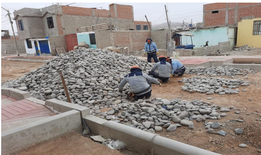
Selección de peones para ejecutar la partida de bermas - trabajos en concreto espesor 15 cm. terminado en canto rodado, realizan trabajos contributivo 03 obreros y 01 obrero descansa.
