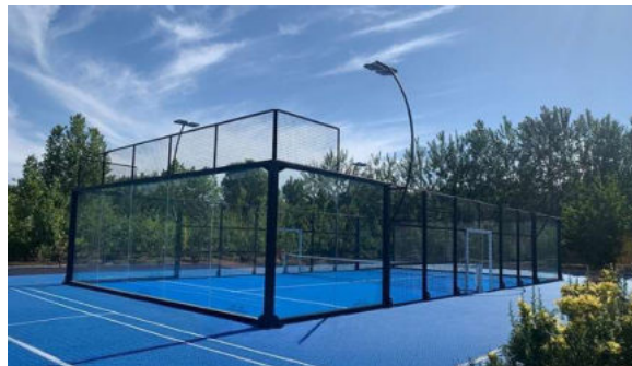
Figura 117. Referencia de estructura metálica con cerramiento en malla poliéster
