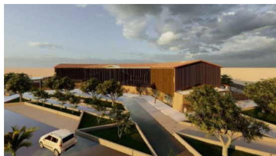
Figura 114. Celosías en la fachada de proyecto
