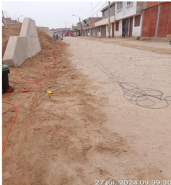
Fotografía 2: Disposición de geófonos para línea sísmica MASW
