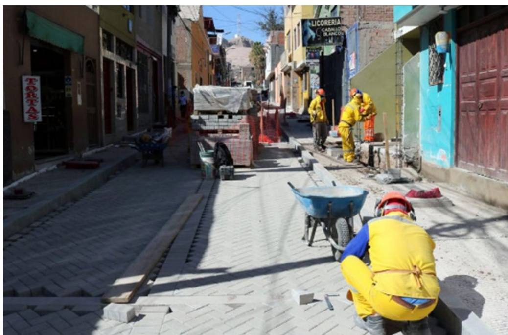
Figura 2 Adoquinado vías zona monumental Moquegua
