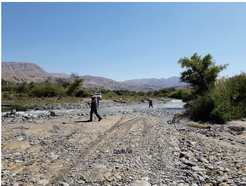
Foto N° 3: Vista de talweg del río Sama a la altura del eje de plinto proyectado. Se pueden ver terrazas bajas que son inundadas con la crecida del río Sama y el talweg puede variar de posición.
