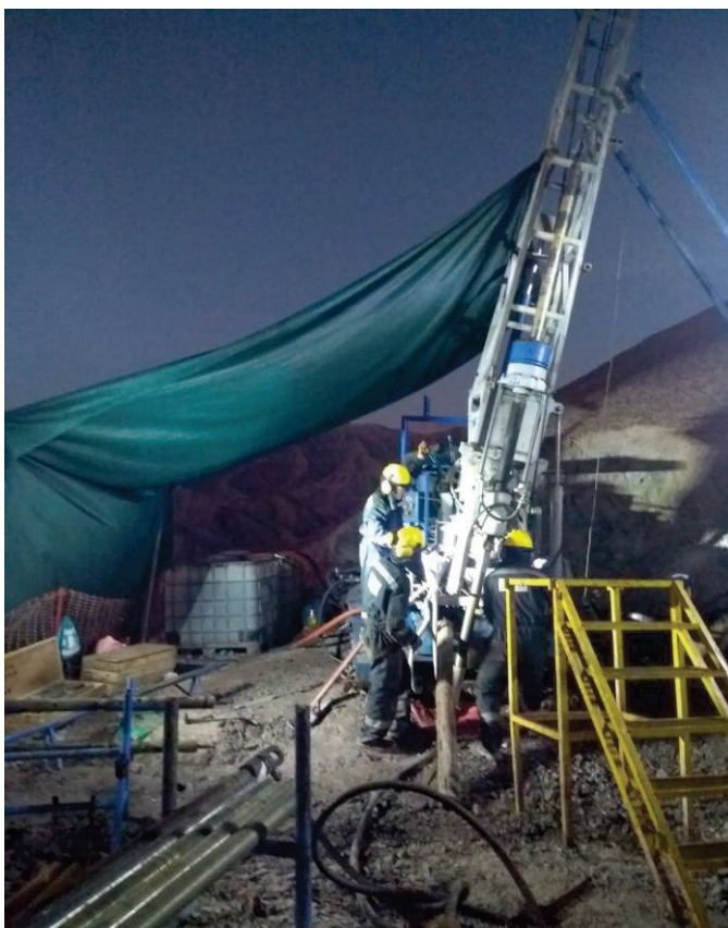
Foto N° 12: Perforación inclinada del taladro TA-02 para estudio del túnel de aliviadero en el macizo del estribo izquierdo.
