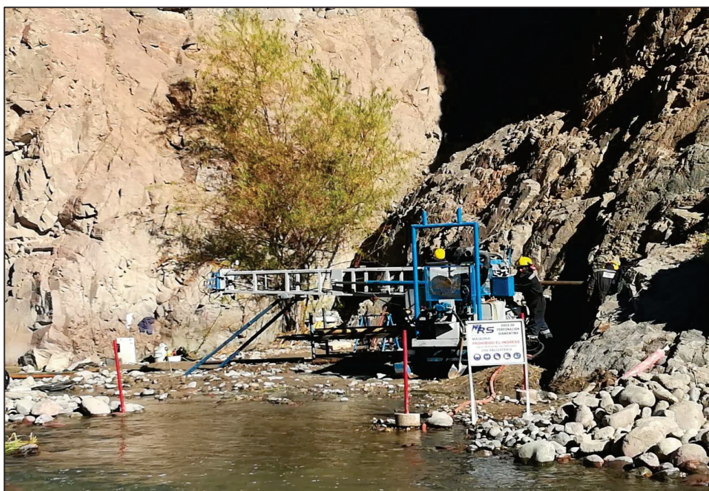
Foto N° 10: Perforación horizontal del taladro TS-05 desde la salida del túnel de desvío para estudio del macizo en el estribo derecho.
