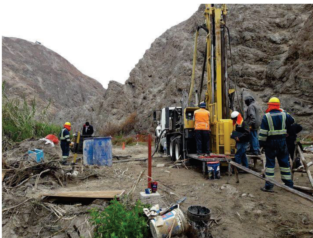
Foto N° 8: Perforación del taladro TS-02 ubicado en la llanura de inundación del río Sama para estudio del eje de plinto y pantalla de inyecciones.
