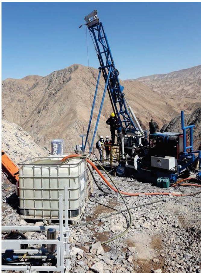
Foto N° 11: Perforación inclinada del taladro TA-03 para estudio del eje del túnel de aliviadero en el margen izquierdo del valle (estribo izquierdo aguas abajo)
