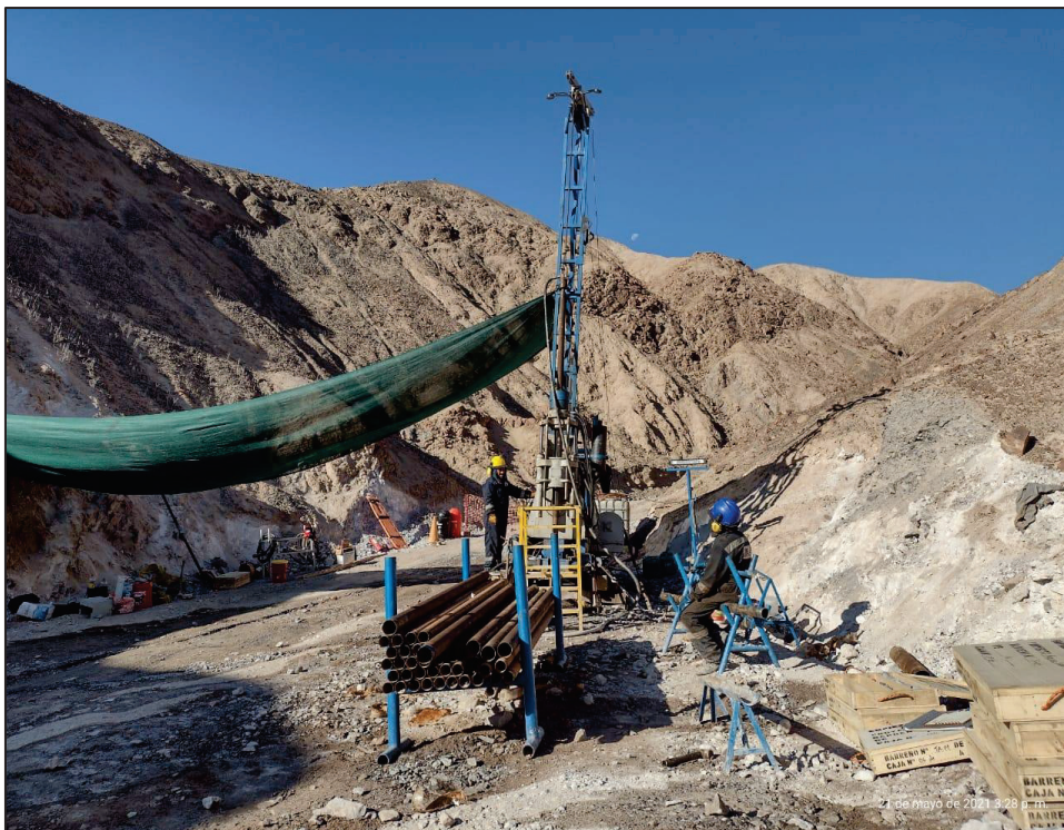
Foto N° 13: Perforación del taladro TA-01 para estudio del estribo izquierdo de la Presa, Aliviadero y túnel de desvío.
