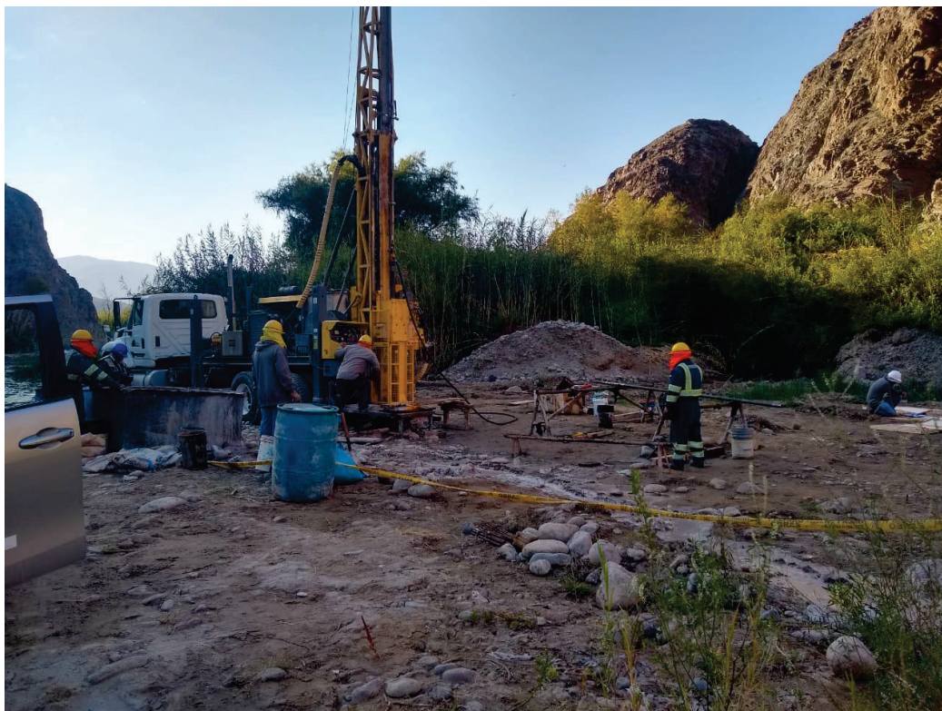
Foto N° 9: Perforación del taladro TS-03 ubicada en la llanura de inundación para estudio del eje de la Atagüa y pantalla de inyecciones (Debajo del Pinto).
