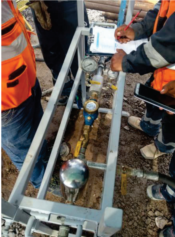
Foto N° 15: Equipo de Lugeon para prueba de permeabilidad en roca.
