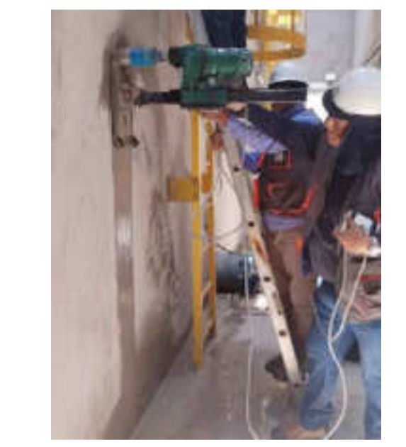
Extracción de muestra de núcleo de concreto mediante perforación diamantada.
