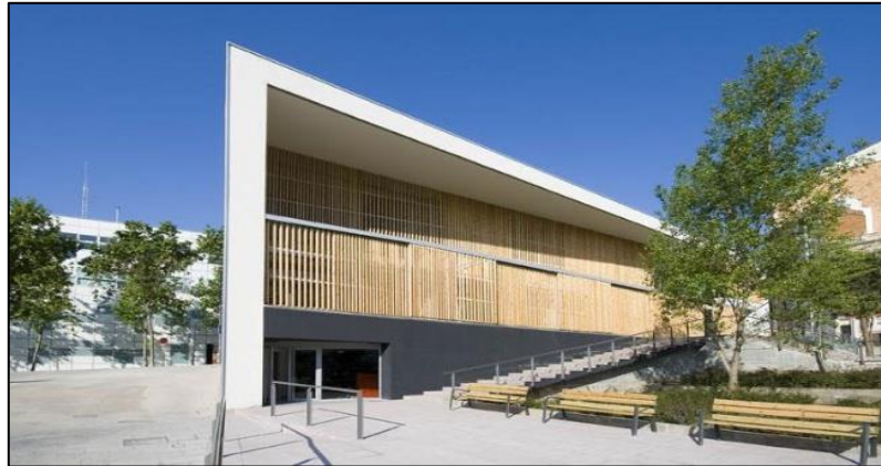
Figura 4. Fachada posterior del proyecto
