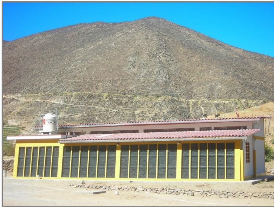
FIGURA 23: SISTEMA PARED COLECTOR DE POSTA MEDICA EN TOQUELA
