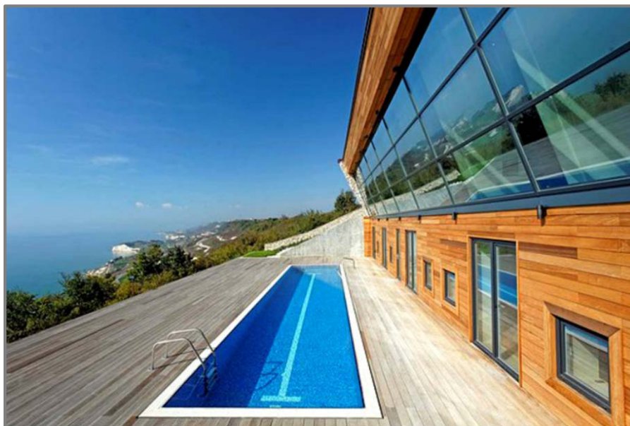
FIGURA 12: INCLINACION EN FACHADA CASA EQUINOX
