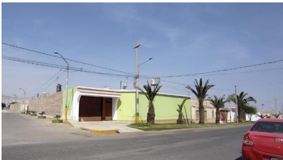
Figura 34. Vivienda construida en ladrillo.
