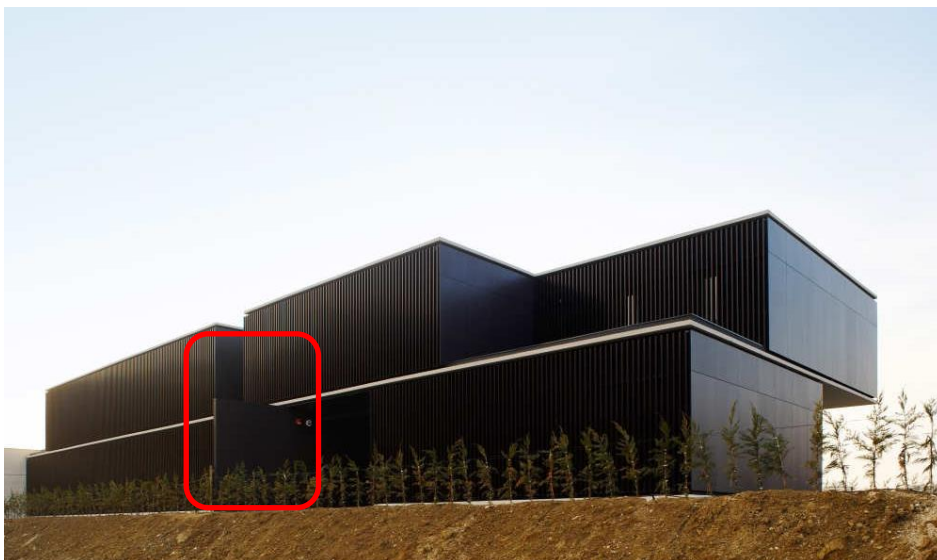
Figura 24: Fachada lateral del Centro de Acogida Pamplona
