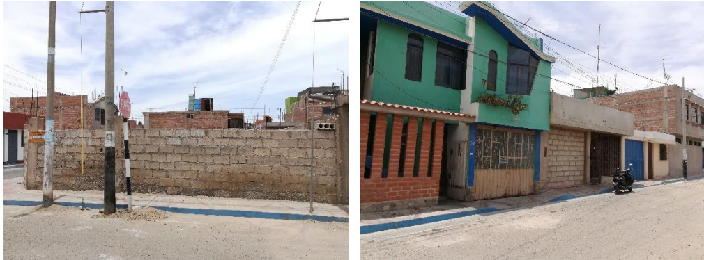
Figura 68: Vista edificaciones y materiales.
