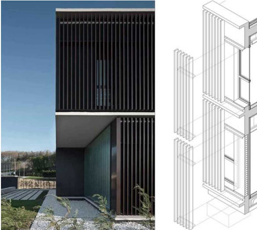
Figura 38: Detalles de celosía
