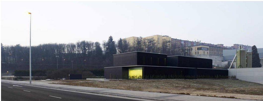
Figura 33: Vista del proyecto
