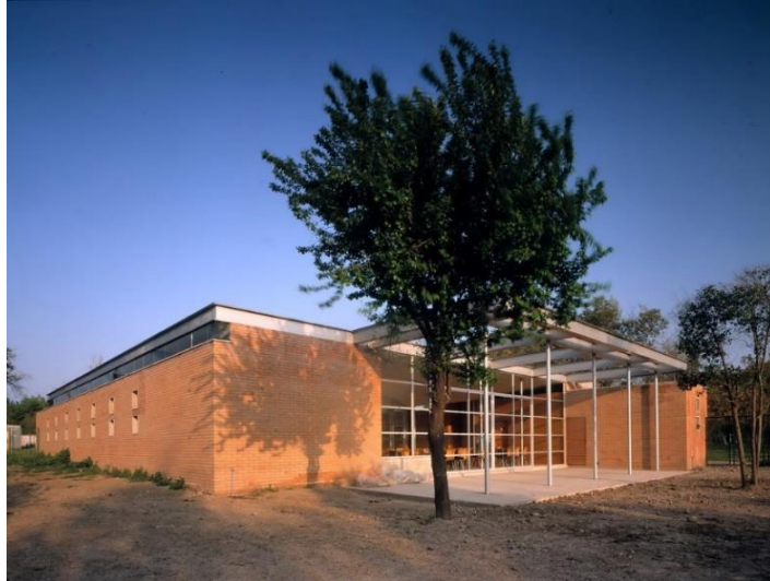
Figura 6: Ingreso principal a la edificación Undurraga Deves
