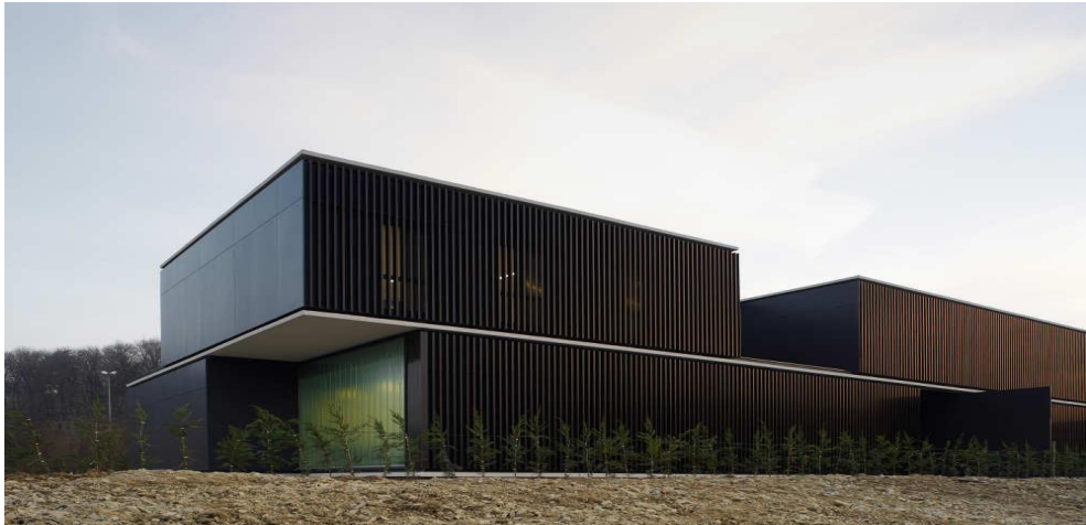
Figura 23: Fachada muro ciego
