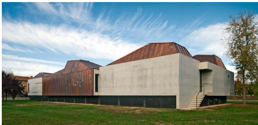
Figura 3: Vista exterior del Centro de Interpretación
