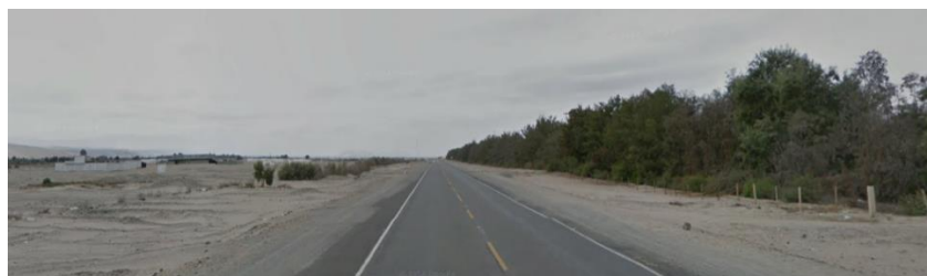
Figura 55: Carretera Costanera Sur
