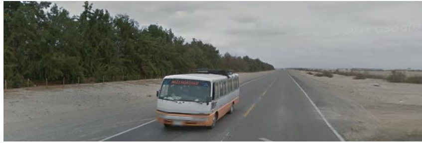
Figura 58: Carretera Costanera Sur
