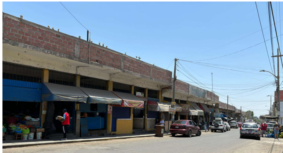
Figura 23. Fachada del mercado.
