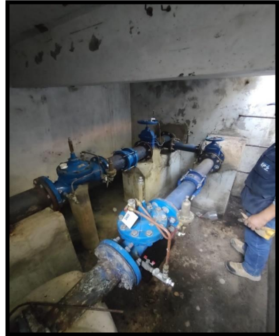
Cámaras de reductoras de presión de la Av. Ejercito y Sector ABC
