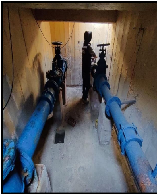
Cámaras de reductoras de presión de la Av. Ejercito y Sector ABC
