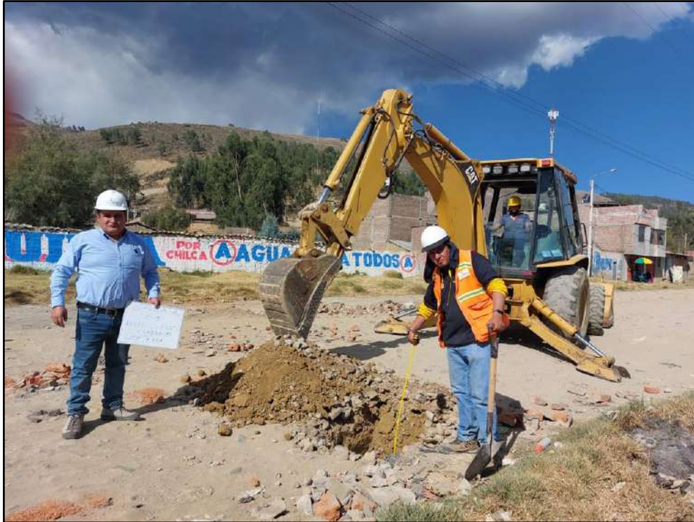
Foto N°03: Vista de la calicata C-3 - Av. Leoncio Prado - Cuadra N°33
