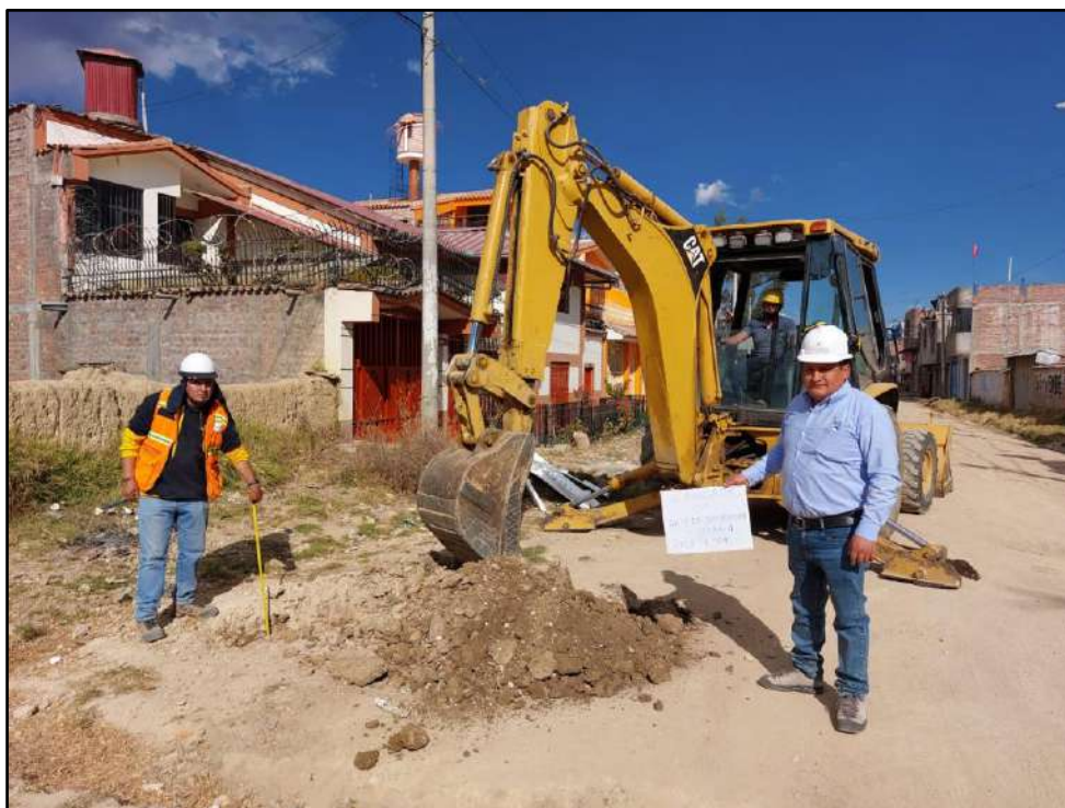
Foto N°07: Vista de la calicata C-1 - Av. 9 de diciembre - Cuadra N°11
