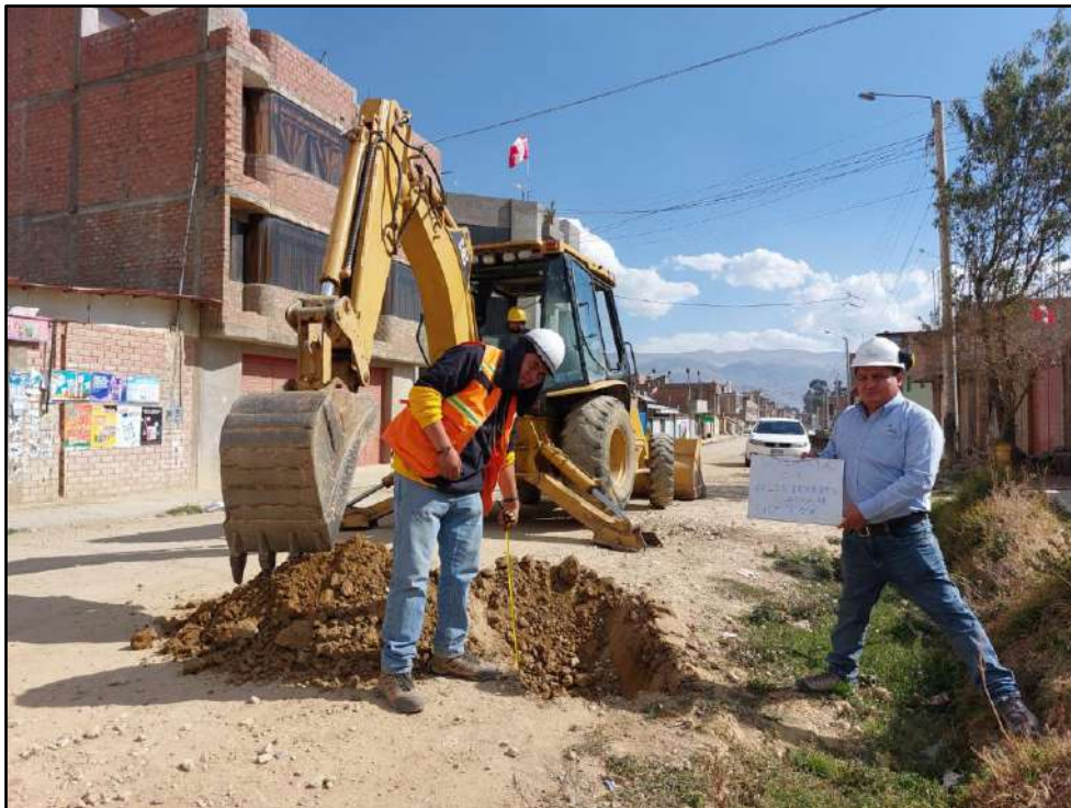
Foto N°04: Vista de la calicata C-1 - Av. Los Próceres - Cuadra N°05
