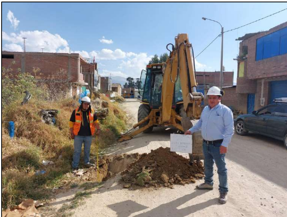
Foto N°06: Vista de la calicata C-3 - Av. Los Próceres - Cuadra N°12
