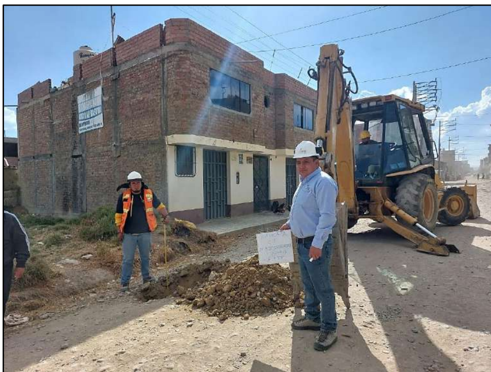
Foto N°08: Vista de la calicata C-2 - Av. 9 de diciembre - Cuadra N°16
