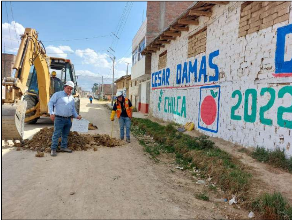
Foto N°05: Vista de la calicata C-2 - Av. Los Próceres - Cuadra N°09
