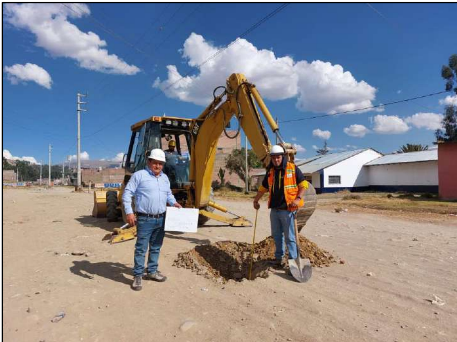
Foto N°02: Vista de la calicata C-2 - Av. Leoncio Prado - Cuadra N°28
