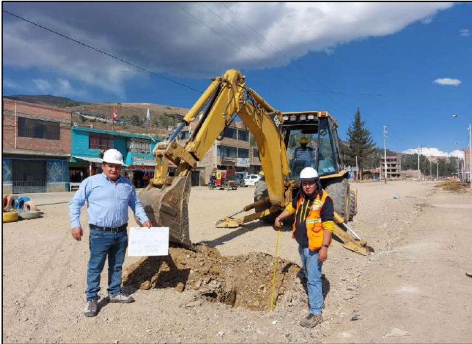
Foto N°01: Vista de la calicata C-1 - Av. Leoncio Prado - Cuadra N°21
