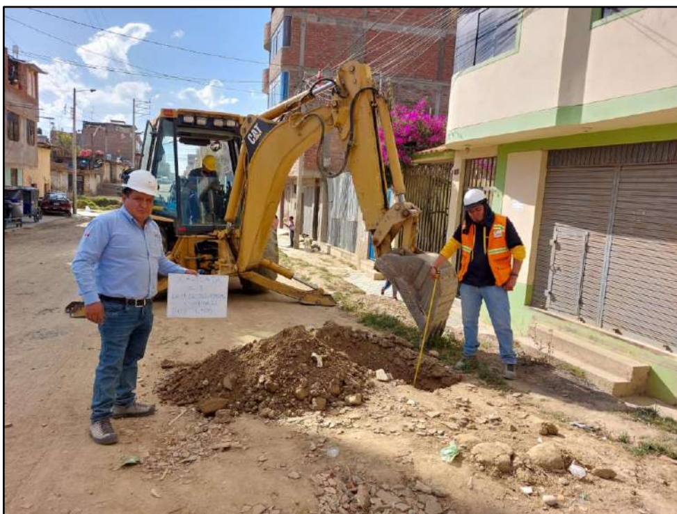
Foto N° 09: Vista de la calicata C-3 - Av. 9 de diciembre - Cuadra N°22
