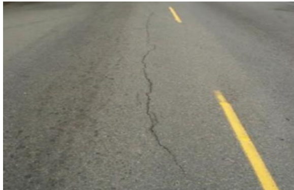
Grietas longitudinales
