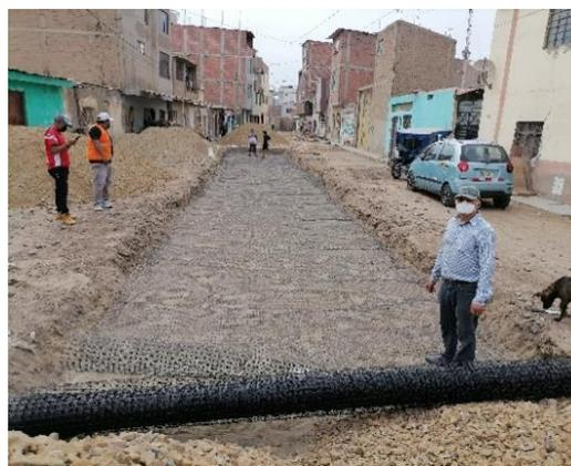
*Nota.* La figura muestra la instalación de la geomalla.
