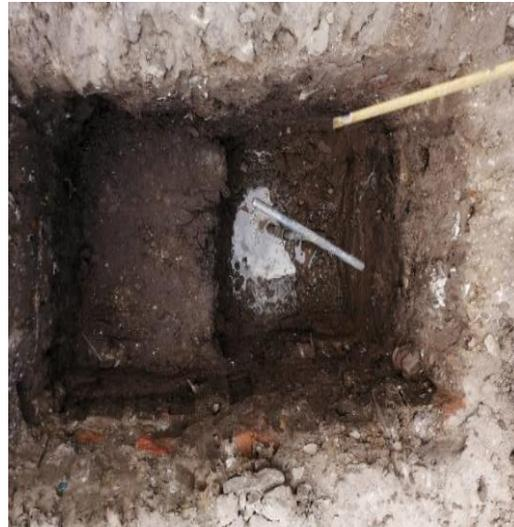
*Nota.* La figura muestra el nivel freático al fondo de excavación de la calicata ejecutada.
