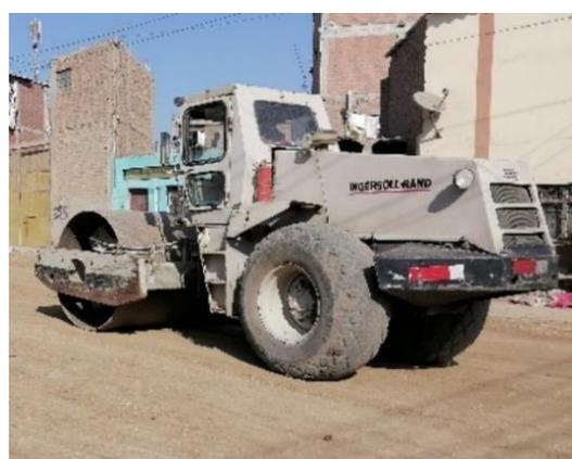
*Nota.* La figura muestra la compactación del material de préstamo con Rodillo Ingersoll rand SD 150 D.
