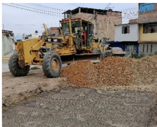
*Nota.* La figura muestra el extendido del material de préstamo con motoniveladora.
