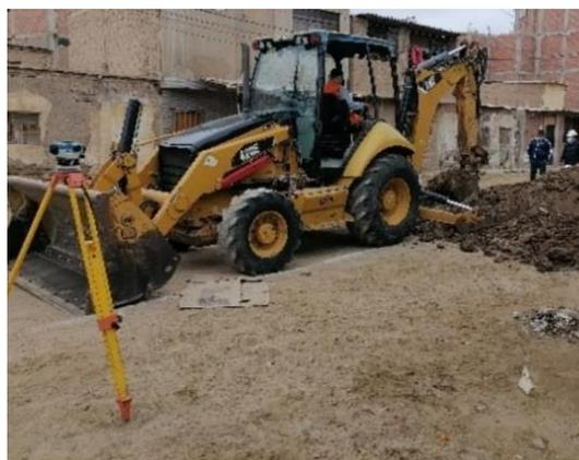
*Nota.* La figura muestra la excavación de 0.45 m de profundidad con retroexcavadora CAT 420 E, en el lugar de prueba.
