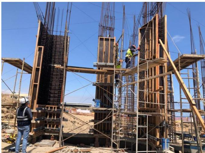
Según la información que se levantó en campo, se pudo observar los materiales que se utilizaron para realizar el encofrado de madera de columnas, tal y como se observa en la tabla 9, sin embargo, para determinar los precios se revisó el acervo documentario de las órdenes de compra que adquirió la obra.
