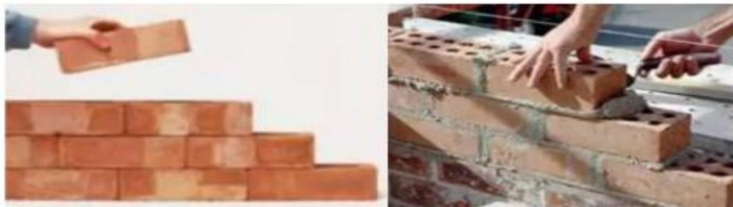
*Nota.* Diseñada para resistir fundamentalmente esfuerzos de compresión de peso propio y cargas verticales menores. Es un muro auto soportante de relleno. Tomado de Construcción I, Por Francisco Vazallo, 2016 (<http://es.slideshare.net/FranciscoVazallo/ladrillo-y-albañileria>)
