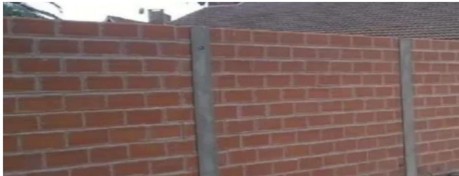
*Nota.* No soporta cargas verticales, solo su propio peso y cargas horizontales. Tomado de Estructuras III, Modulo I, Por Nulpi Vilchez, 2021 (<https://es.slideshare.net/NulpiVilchez/hormign-mampostera-muros-encadenados-muros-portantes-no-portantes-mampuestos>)
