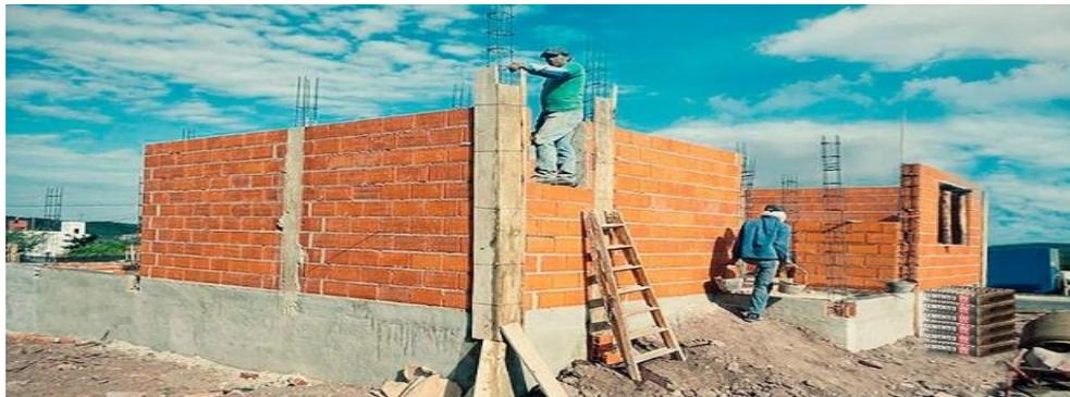
*Nota.* Es aquella conformada por paños de albañilería simple, amarrados elementos de hormigón armado, tales como cadenas y pilares. Tomado de Construcción I, Por Francisco Vazallo, 2016 (<https://es.slideshare.net/FranciscoVazallo/ladrillo-y-albaileria>)
