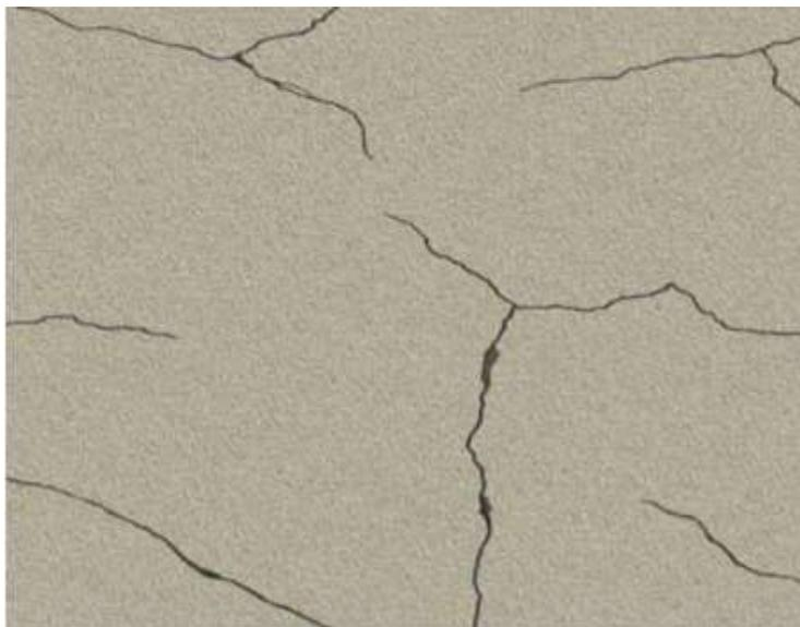
Nota. Las fisuras comprometen la rigidez, la durabilidad y la impermeabilidad, además de la estética. Fuente: Rehabilitación, fisuras en el concreto reforzado (SIKA, 2014).
