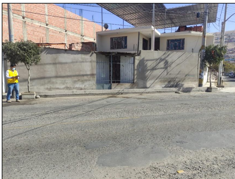
Fotografía 4. Vivienda con Pequeño muro de Protección para aguas de lluvia, huaicos, reboce de buzones de más arriba.
