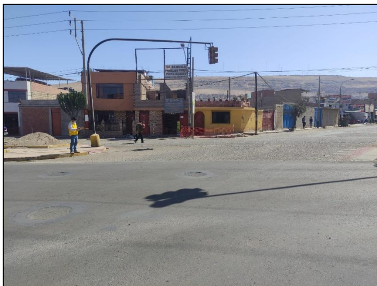
Fotografía 6. Final del colector primario de la avenida Tarata intersección con la avenida Industrial.
