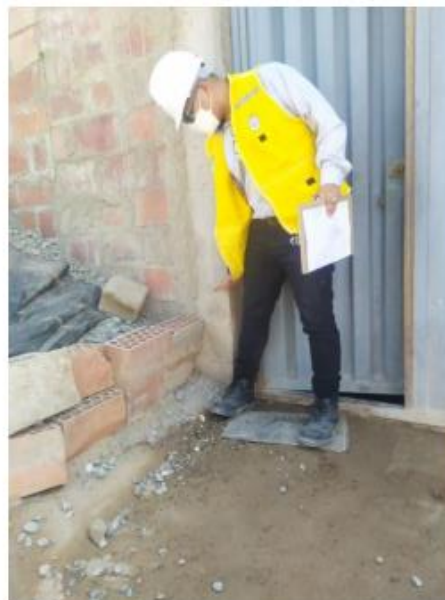
FOTO N° 29 IDENTIFICACIÓN DE ALTURA DE INUNDACIÓN POR HUAYCO EN FECHA DE FEBRERO 2020 EN ZONA MEDIANAMENTE ALEJADO A LA QUEBRADA CARAMOLLE
