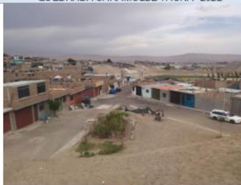
FOTO N° 83 FOTO DE ZERPAR DE CIUDAD NUEVA ZONA ALEJADA A LA QUEBRADA CARAMOLL ETACNA - 2022
