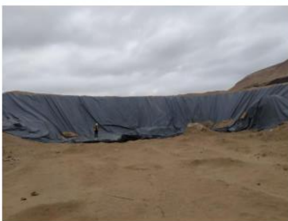
FOTO N° 07 PODEMOS APRECIAR UN DIQUE HECHO DE MATERIAL SOBRANTE EN OBRAS REALIZADAS EN LA JURISDICCION DEL SECTOR DE QUEBRADA CARAMOLLE - TACNA
