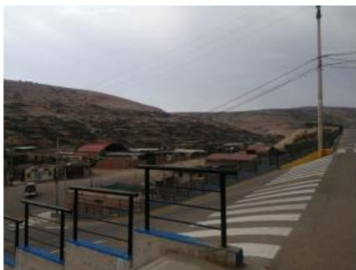
FOTO N° 47 SE OBSERVA PAVIMENTO CON PENDIENTE ELEVADA PARA EVITAR RIESGO DE HUAYCO – QUEBRADA CARAMOLLE TACNA 2022
