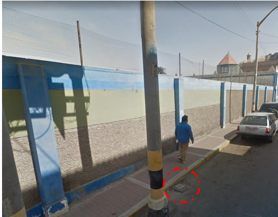
Figura 44. Vista de caja de registro mas cercana al proyecto.
