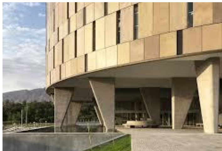
Figura 24. Imagen exterior del edificio
