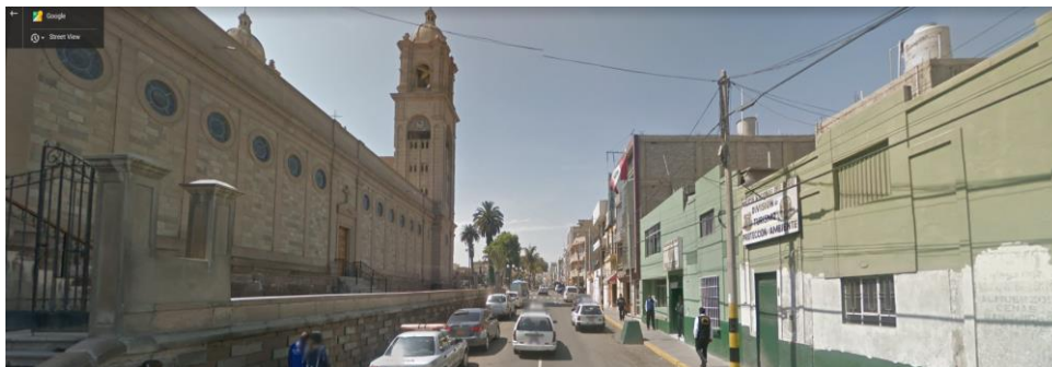
Figura 37. Vista calle Callao sentido norte
