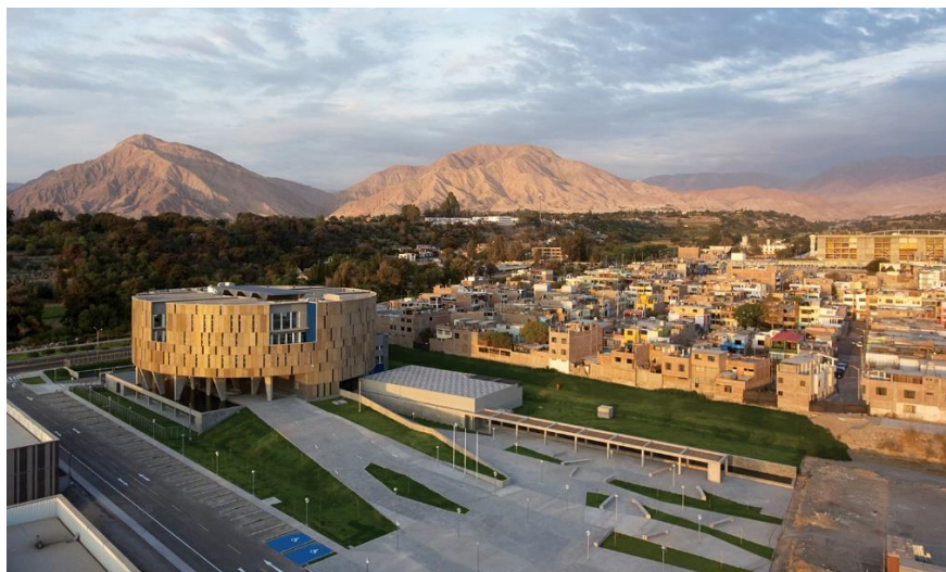
Figura 21. Imagen del edificio y el contexto de la ciudad
