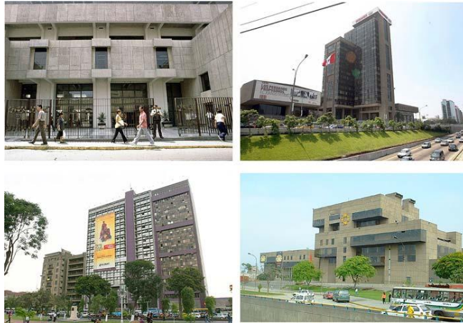
Figura 13. Edificios públicos construidos en Lima década de 1970..
