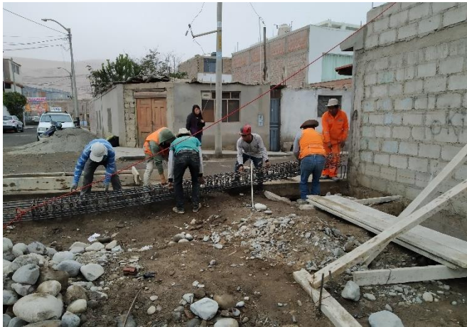
FIGURA 53: Colocación de acero en columnas (obra 3)
