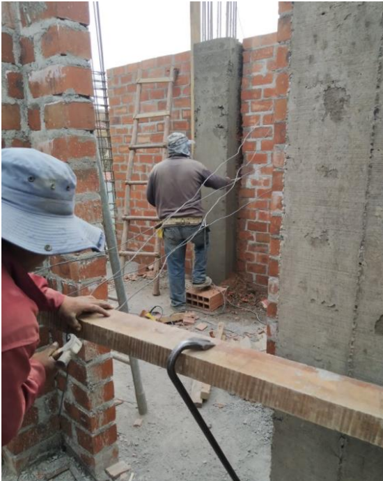
FIGURA 20: Corrección de errores en obra (obra 1)
