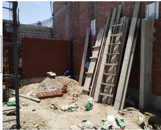
FIGURA 28: Habilitación de encofrado para columnas (obra 2)
