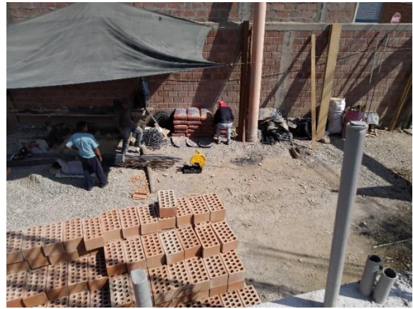
FIGURA 07: Habilitación de acero en columnas (obra 1)
