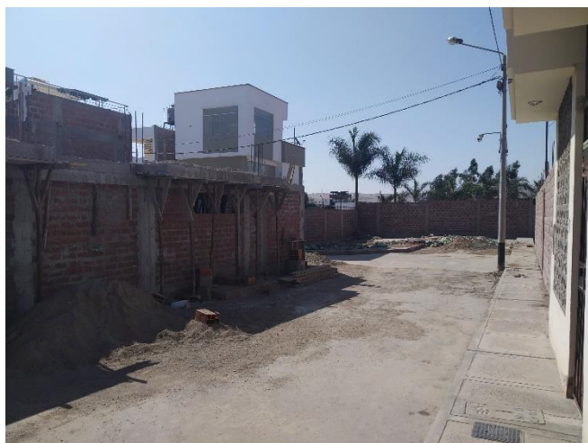
FIGURA 38: Encofrado de losas (obra 2)
