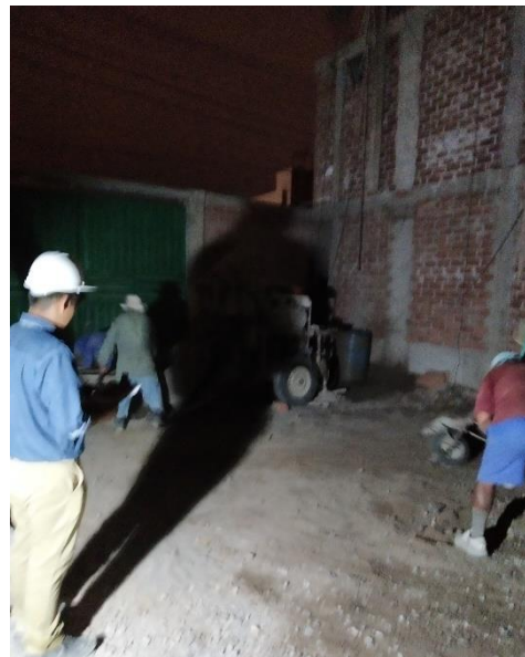
FIGURA 18: Vaciado de concreto en losa (obra 1)
