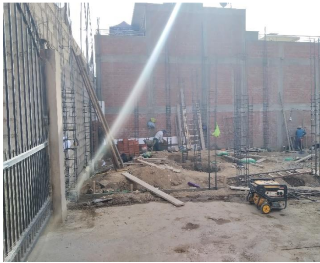
FIGURA 32: Acero en columnas (obra 2)
