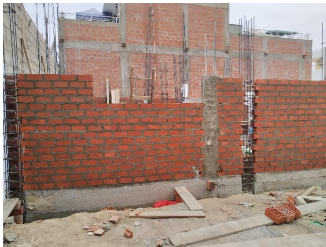
FIGURA 41: Asentado de muro (obra 2)
