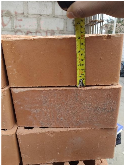
FIGURA 59: Medida de ladrillo para asentado de muro (obra 3)
