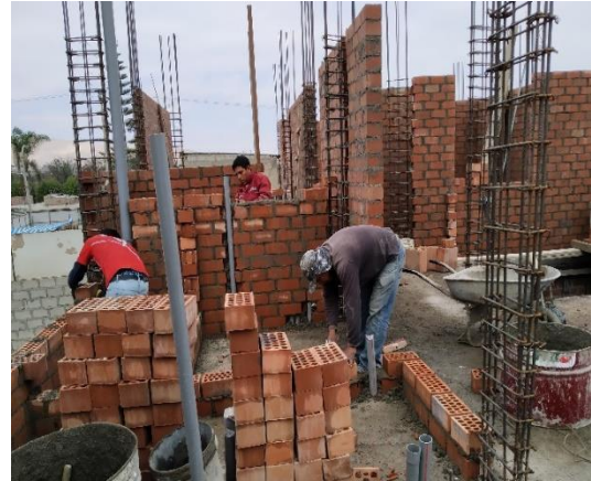
FIGURA 22: Asentado de muro (obra 1)
