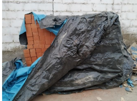
FIGURA 61: Almacenamiento de ladrillo para asentado de muro (obra 3)
