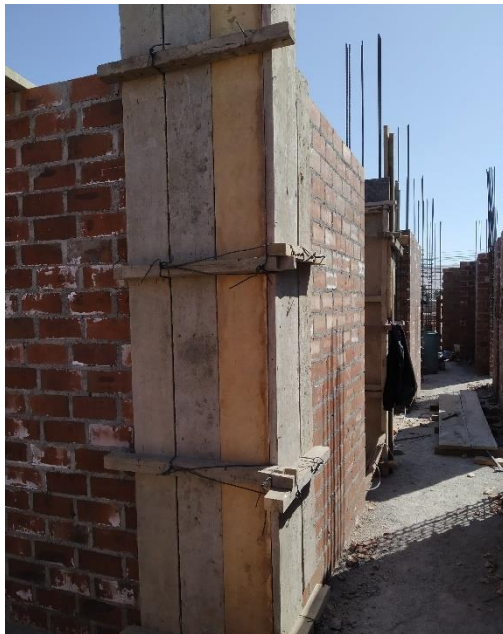
FIGURA 05: Encofrado de Columnas (obra 1)
