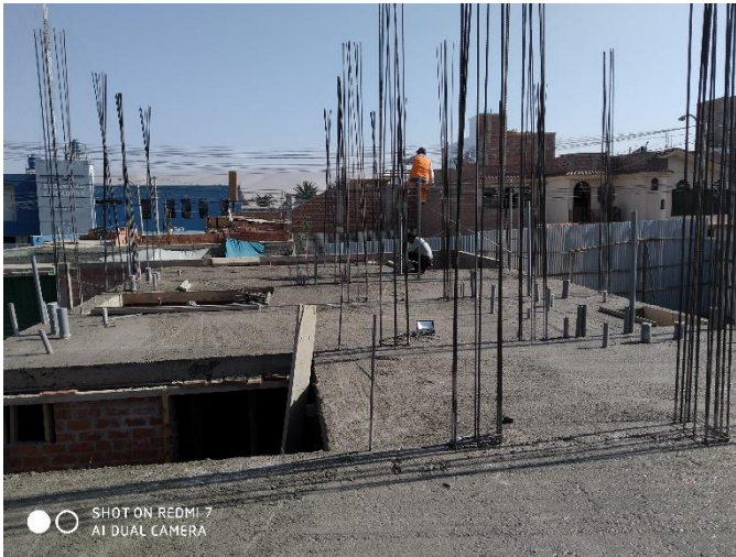
FIGURA 08: Colocación de acero en columnas (obra 1)
