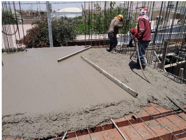
FIGURA 74: Vaciado de losa (obra 3)
