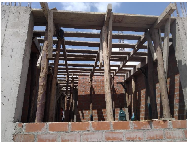
FIGURA 65: Encofrado de losas (obra 3)
