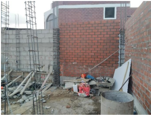
FIGURA 62: Asentado de muro (obra 3)
