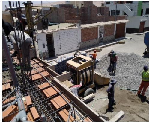
FIGURA 70: Preparación de mezcla para vaciado de losa (obra 3)
