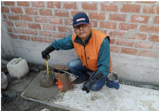
FIGURA 02: Haciendo la prueba del Slump con el cono de abrams (obra 1)
