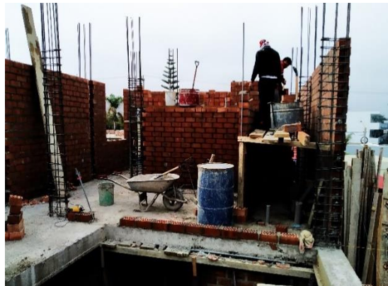
FIGURA 21: Asentado de muro (obra 1)
