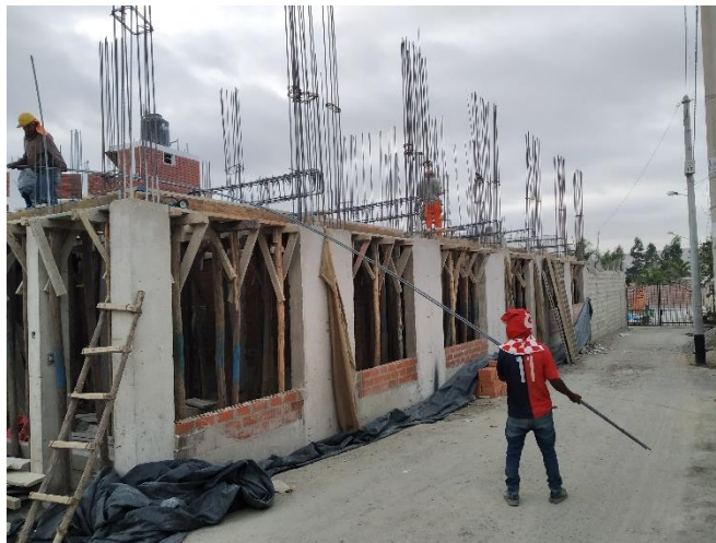
FIGURA 68: Acero y encofrado en losa (obra 3)
