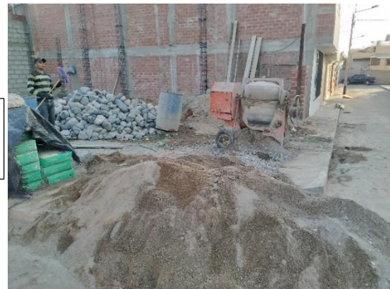
FIGURA 27: Material en obra para preparación de mezcla (obra 2)
