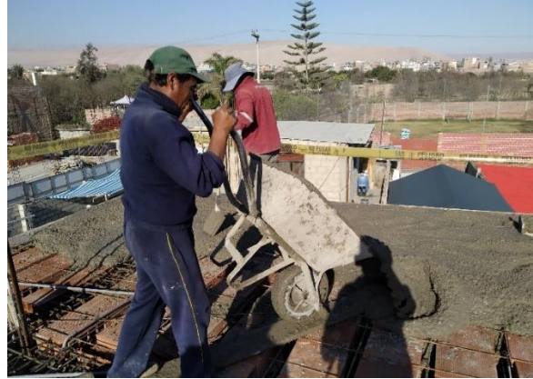
FIGURA 10: Concreto en vigas y losas (obra 1)
