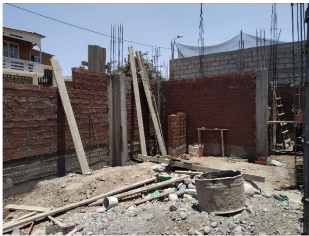
FIGURA 29: Desencofrado de columnas (obra 2)
