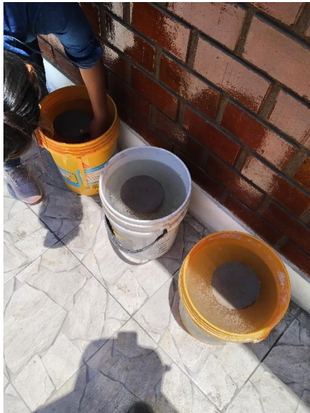
FIGURA 71: Preparación de briquetas para concreto en losa (obra 3)
