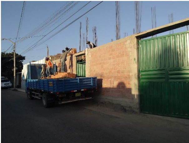
FIGURA 23: Acarreo de material para asentado de muro (obra 1)
