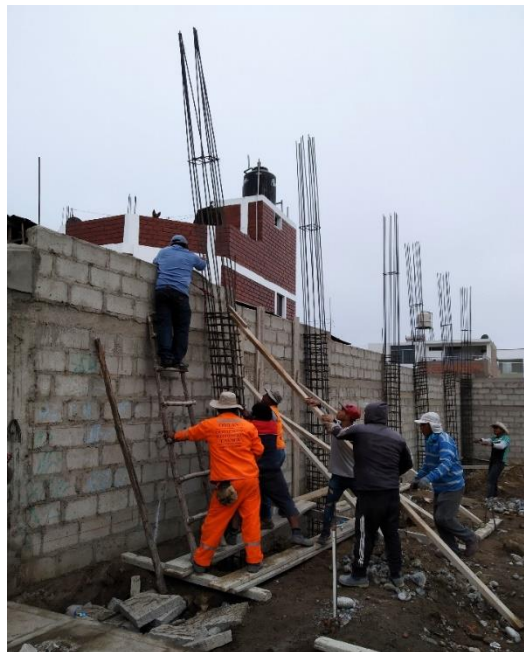
FIGURA 54: Colocación de acero en columnas (obra 3)
