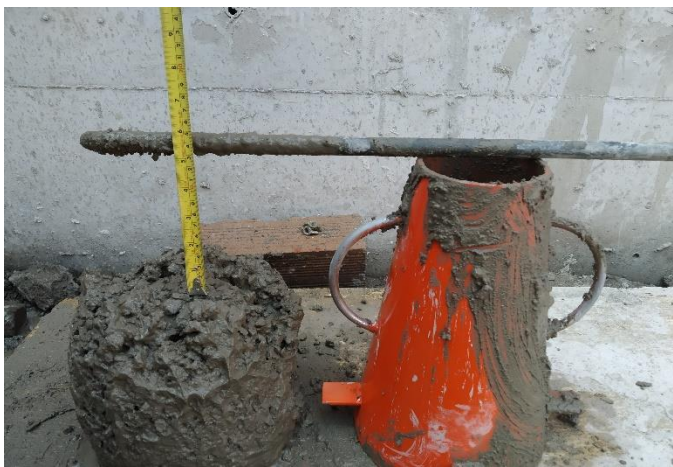
FIGURA 11: Verificación de Slump en concreto de vigas y losas (obra 1)
