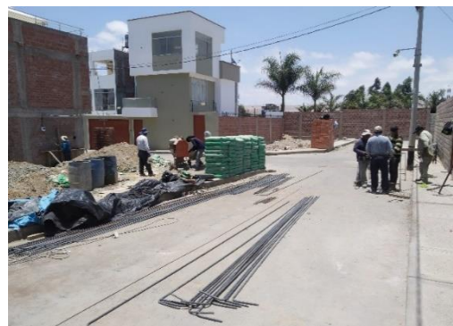
FIGURA 30: Habilitación de acero para columnas (obra 2)
