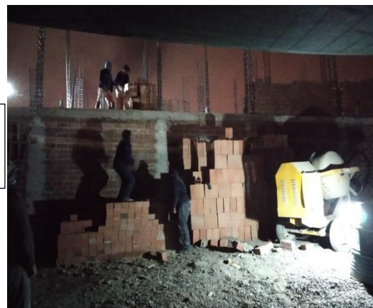
FIGURA 24: Acarreo de material para asentado de muro (obra 1)
