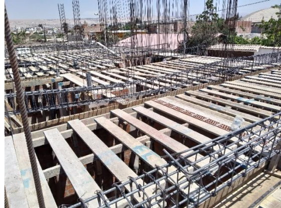
FIGURA 67: Acero en vigas (obra 3)
