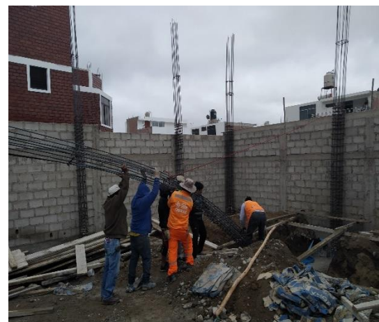
FIGURA 51: Colocación de acero en columna (obra 3)
