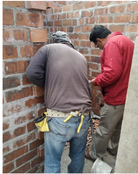
FIGURA 16: Supervisión de Trabajos (obra 1)
