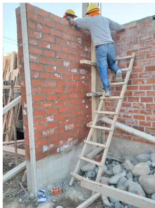
FIGURA 48: Encofrado en columnas (obra 3)
