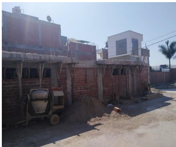
FIGURA 37: Encofrado de losas (obra 2)
