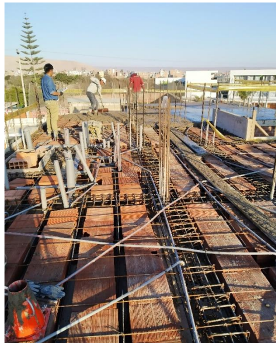
FIGURA 12: Vaciado de concreto en vigas y losas (obra 1)
