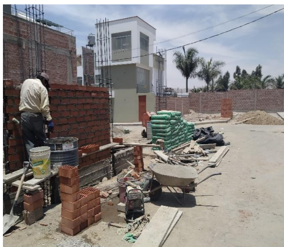
FIGURA 39: Asentado de muro (obra 2)
