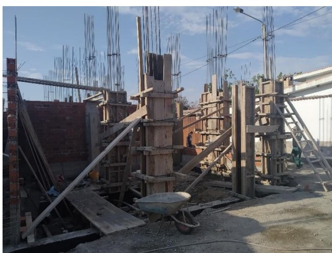
FIGURA 47: Encofrado en columnas (obra 3)
