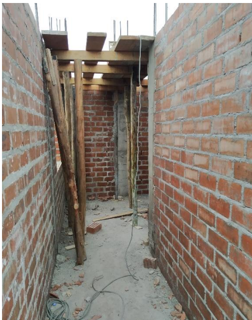
FIGURA 14: Encofrado de losa (obra 1)
