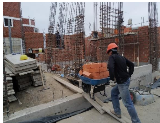
FIGURA 60: Acarreo de ladrillo para asentado de muro (obra 3)
