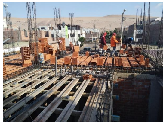
FIGURA 69: Colocación de ladrillo para techo (obra 3)
