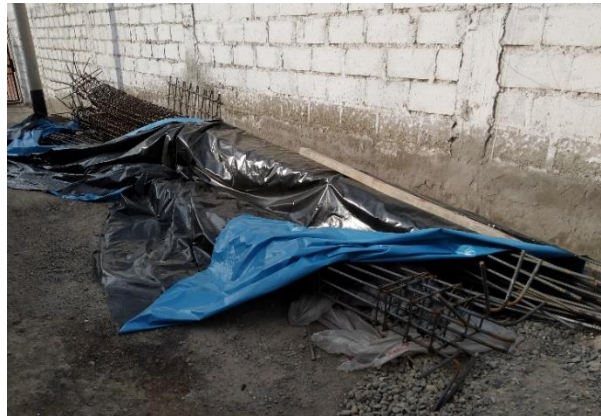
FIGURA 50: Acero en columnas listo para colocación (obra 3)
