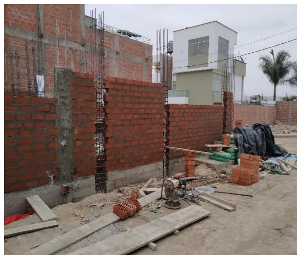
FIGURA 42: Asentado de muro (obra 2)
