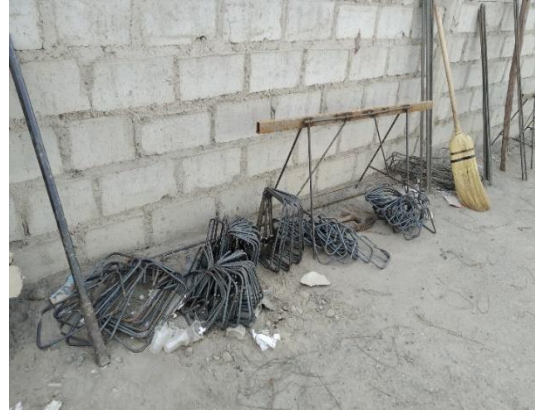
FIGURA 52: Estribos para acero en columnas (obra 3)
