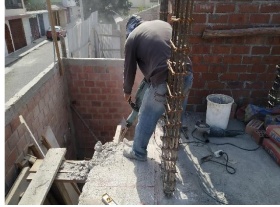
FIGURA 19: Corrección de errores en obra (obra 1)
