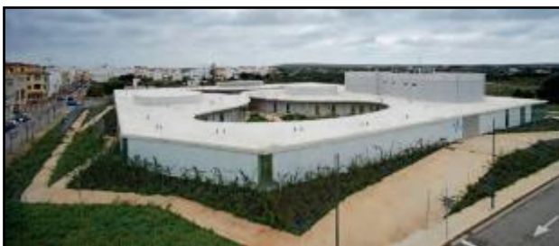
FIG. N° 08. FOTO CENTRO GERIATRICO SANTA ROSA
