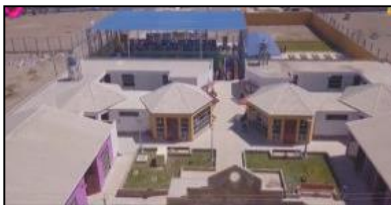
FIG. N° 51. IMAGEN – VISTA AEREA DEL CENTRO RECREACIONAL DEL ADULTO MAYOR
