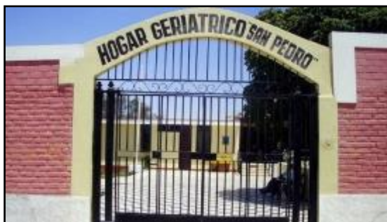
FIG. N° 48. IMAGEN – VISTA PEATONAL DEL INGRESO DEL HOGAR GERIATRICO “SAN PEDRO”.
