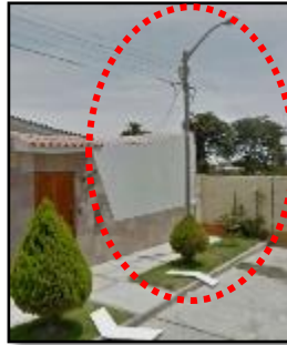
FIG. N° 86. Servicio de energía eléctrica
