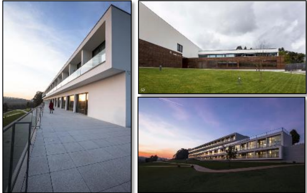
FIG. N° 31. IMÁGENES EXTERIORES DEL CENTRO DE RESIDENCIA
