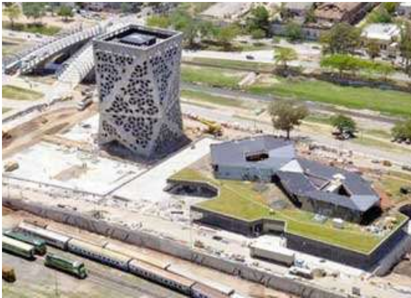
Figura 12 Vista aérea del Centro cívico Bicentenario
