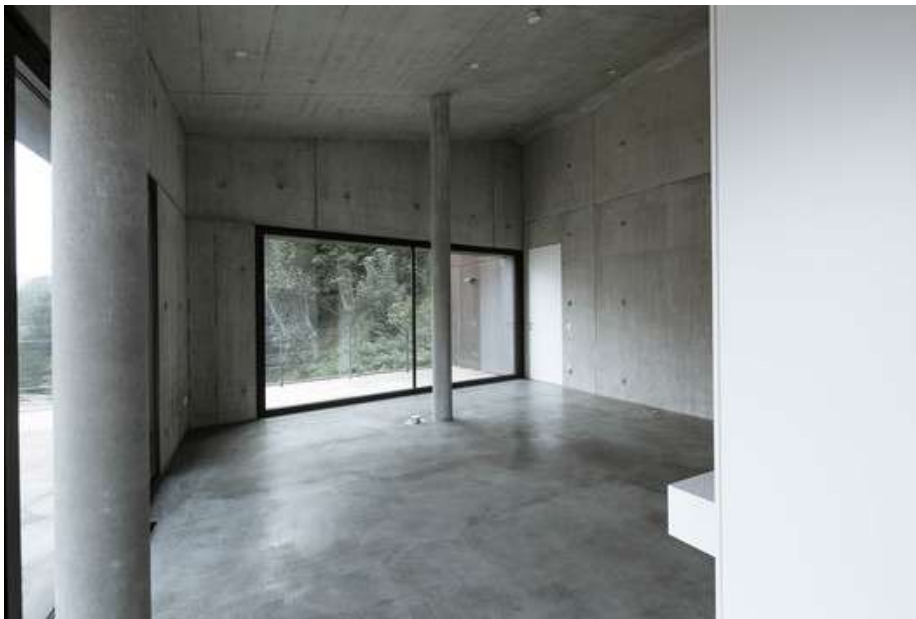
Concreto en edificios
