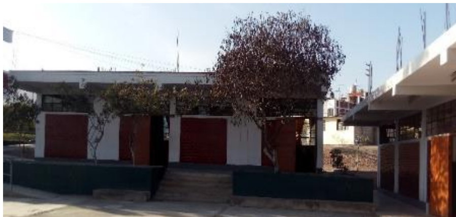
Figura 77 Vista de bloque E y F
