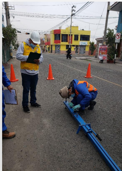
Fotografías: Posicionamiento del vehículo en el punto de lectura, y toma de lecturas.
