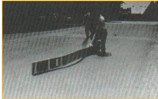
Figura 72: “Desplazamiento de Baja Severidad”
