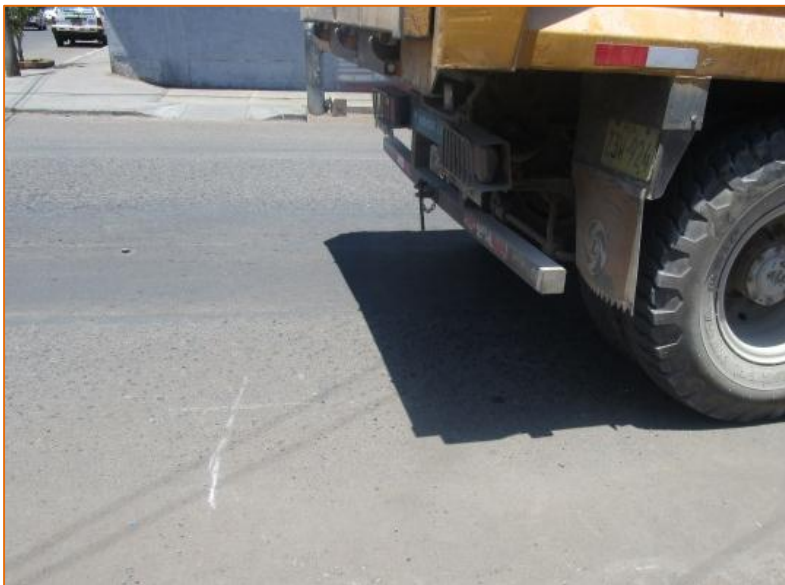
Figura 84: Punto del pavimento a ser ensayado con la Viga Benkelman
