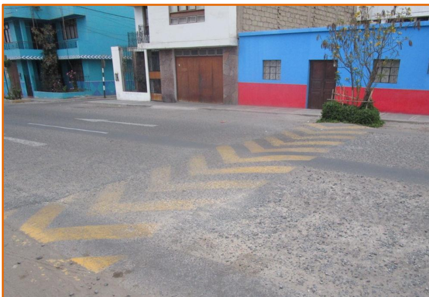
Figura 12: Segundo Reductor de Velocidad Tipo Resalto
