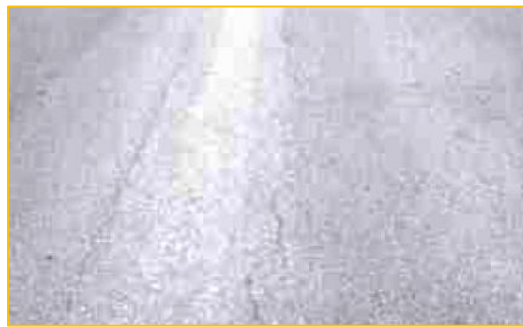
Figura 29: “Piel de Cocodrilo de Baja Severidad”
