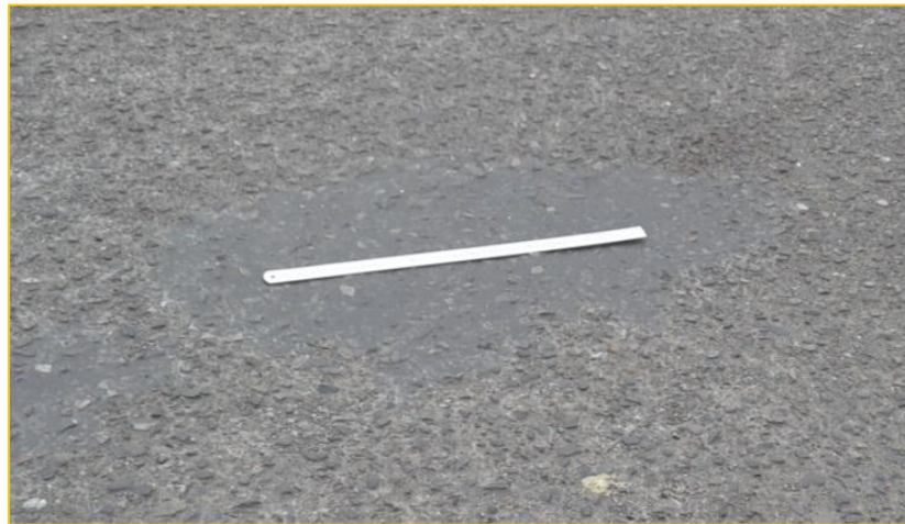
Figura 105: Exudación de Severidad baja.
