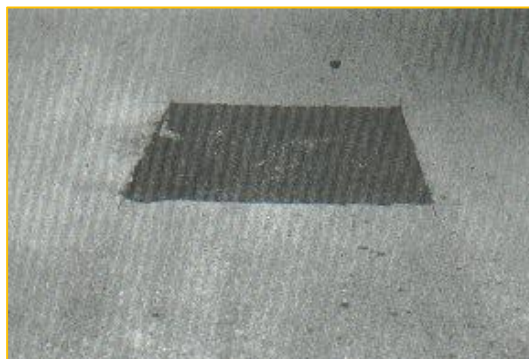
Figura 59: “Parcheo de Severidad Baja”
