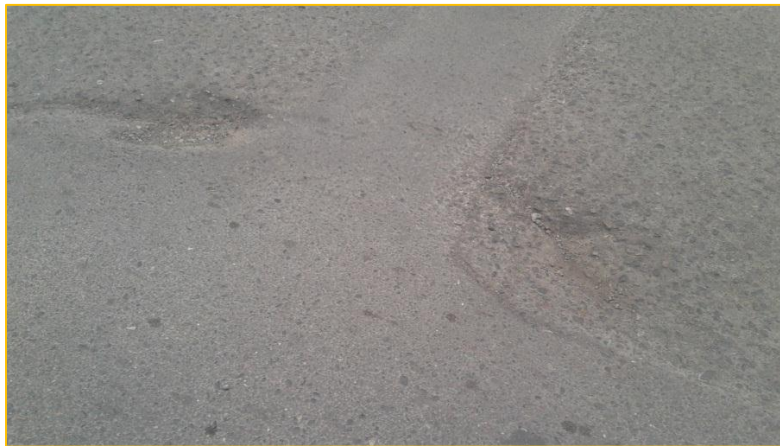
Figura 102: Abultamientos y Hundimientos de diferente Severidad
