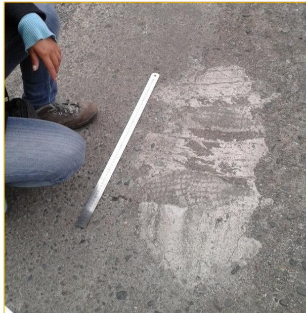
Figura 106: Parches de severidad media.
