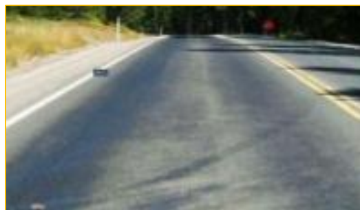
Figura 32: “Exudación de Severidad Baja”
