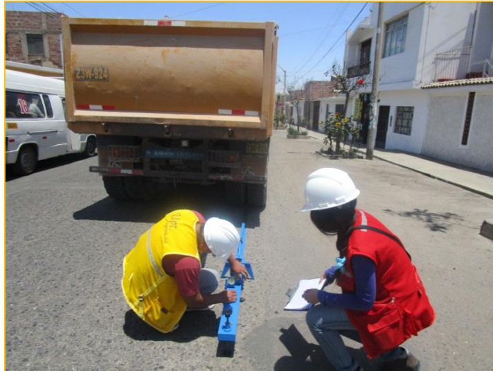
Figura 108: Calibración de la Viga Benkelman – Carril Derecho.
