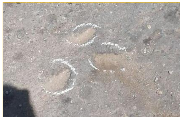
Figura 95: Huecos en diferentes severidades.
