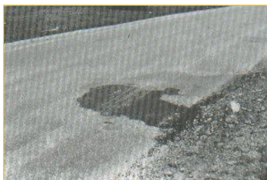
Figura 60: “Parcheo de Severidad Media”
