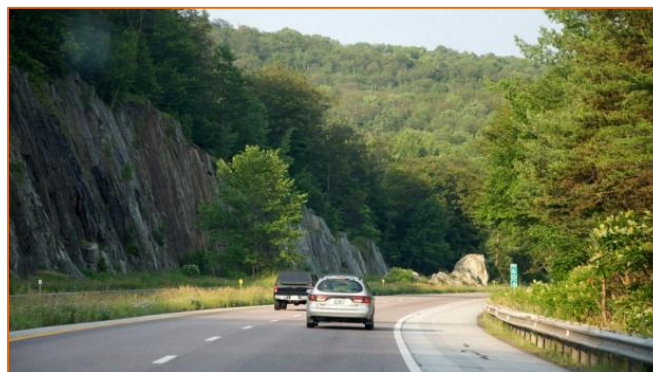
Figura 13: Vía de circulación o Carretera
