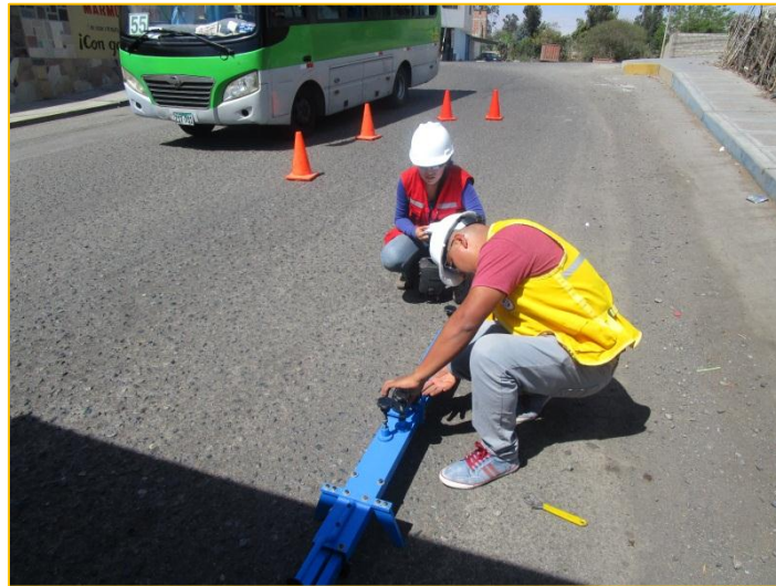
Figura 111: Toma de medidas de la Viga Benkelman - Carril Izquierdo.
