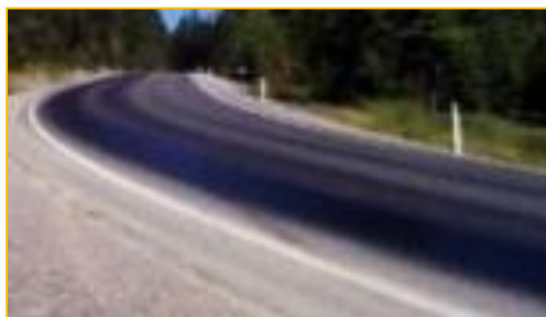
Figura 34: “Exudación de Severidad Alta”
