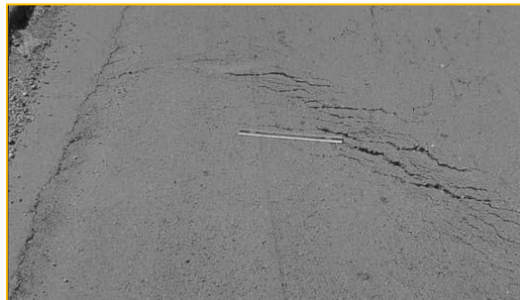
Figura 76: “Grieta Parabólica de Severidad Media”
