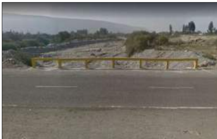
Figura 10: Puentes viales TA -615 Fuente: Propia
