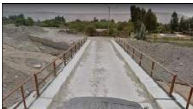
Figura 11: Puente vial – Pachía Fuente: Propio
