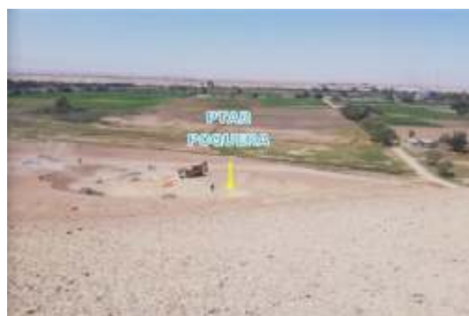
Figura 12. Obra de saneamiento de la Municipalidad Distrital de Inclán
