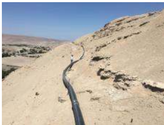
Figura 5. Obra de saneamiento de la Municipalidad Provincial de Jorge Basadre
