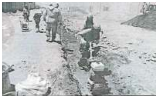
Figura 11. Obra de saneamiento de la Municipalidad Distrital de Gregorio Albarracín Lanchipa
