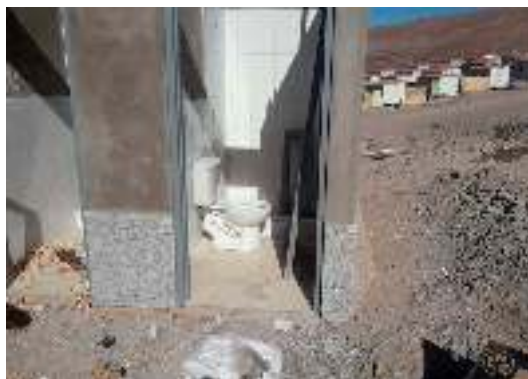
Figura 6. Obra de saneamiento de la Municipalidad Distrital de Ilabaya
