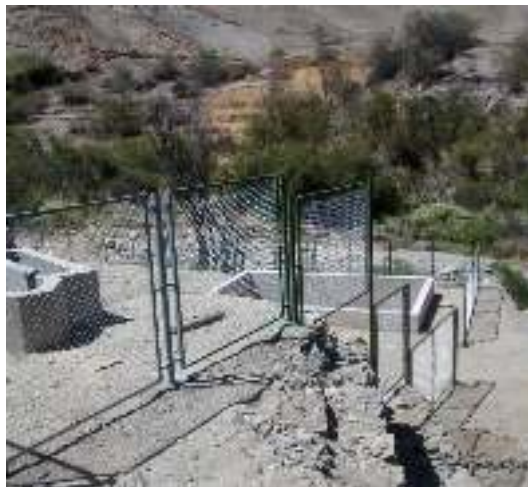
Figura 7. Obra de saneamiento de la Municipalidad Distrital de Héroes Albarracín
