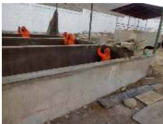
Figura 9. Obra de saneamiento de la Municipalidad Distrital de Calana
