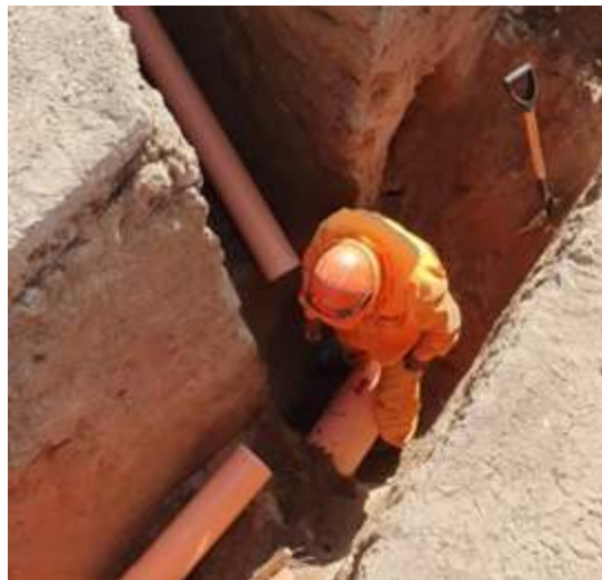
Figura 10. Obra de saneamiento de la Municipalidad Distrital de Ciudad Nueva
