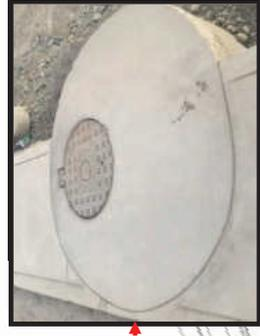
**Figura 87.** Buzón de alcantarillado
