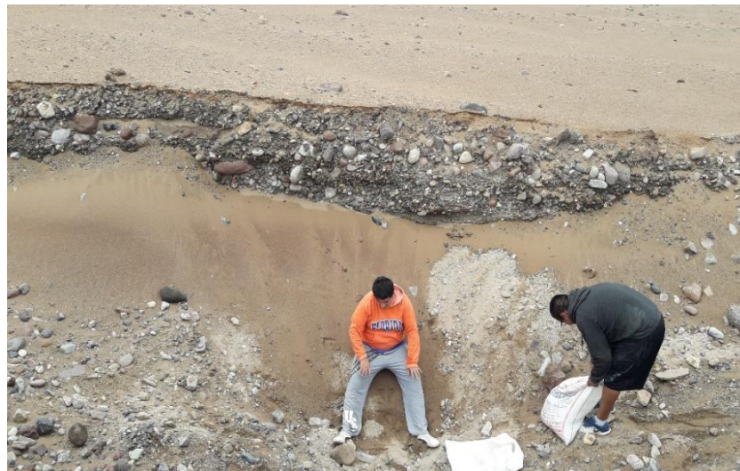
Fotografía 15 Calicata N° 01 en Sama (Propuesta de Cantera), se observa la extracción del material.
