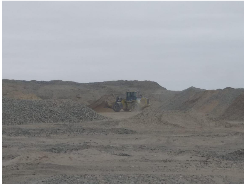
Fotografía 4 Con apoyo del Cargador Frontal se realiza el zarandeo para la eliminación de rocas.
