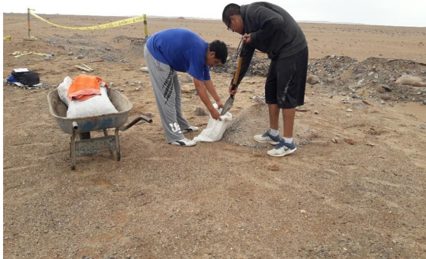
Fotografía 17 Se realizó el zarandeo del Material retirado de la Calicata para obtener Arena Gruesa.
