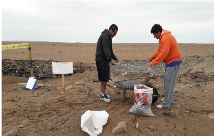
Fotografía 16 Se realizó el zarandeo del Material retirado de la Calicata para obtener piedra de 3/4".
