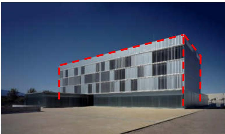
La envolvente exterior se materializa con una doble piel. En la caja superior un primer filtro exterior -de lamas móviles de chapa de aluminio perforada en fachadas Este y Oeste- protege del soleamiento la hoja interior de vidrio. En las piezas del basamento la piel exterior es de u-glass, para permitir el paso de la luz y proteger de las vistas, y la interior de vidrio.
