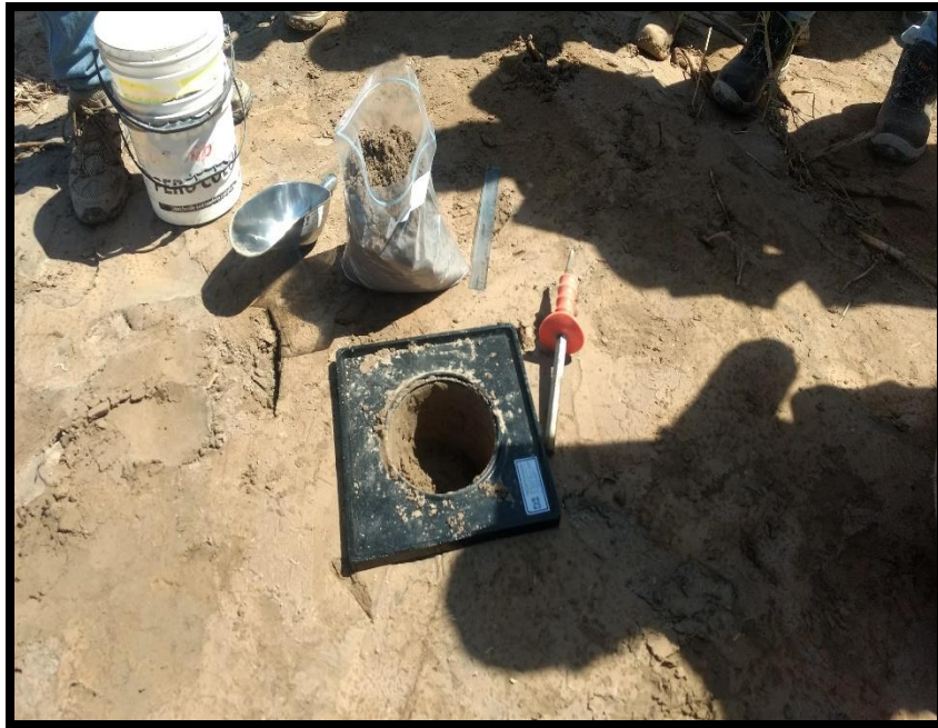
Fotografía N° 3 Determinación de densidad in situ mediante cono de arena
