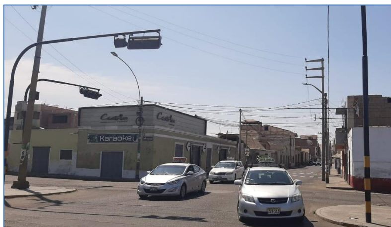
Figura N° 21: Av. Arias Aragüez con dirección hacia la calle Olga Grohman.
