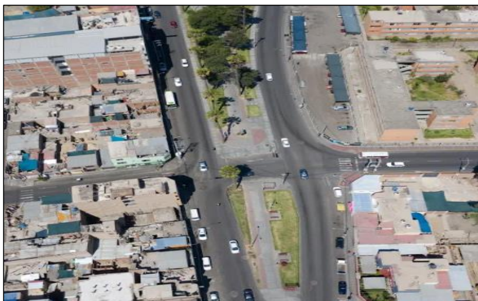
Figura N° 7: Vista de la intersección III.
