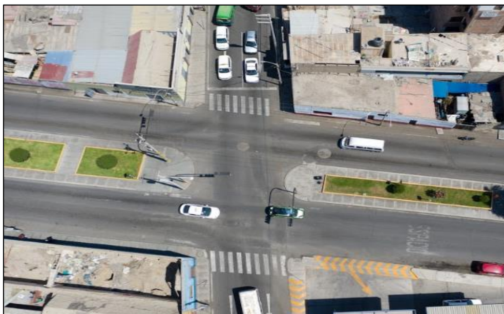
Figura N° 5: Vista de la intersección I.
