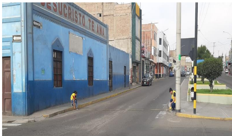
Imagen 3: Se aprecia las mediciones en campo del ancho de la vía de Av. Leguía – Av. Arias y Aragüez en la Intersección I.
