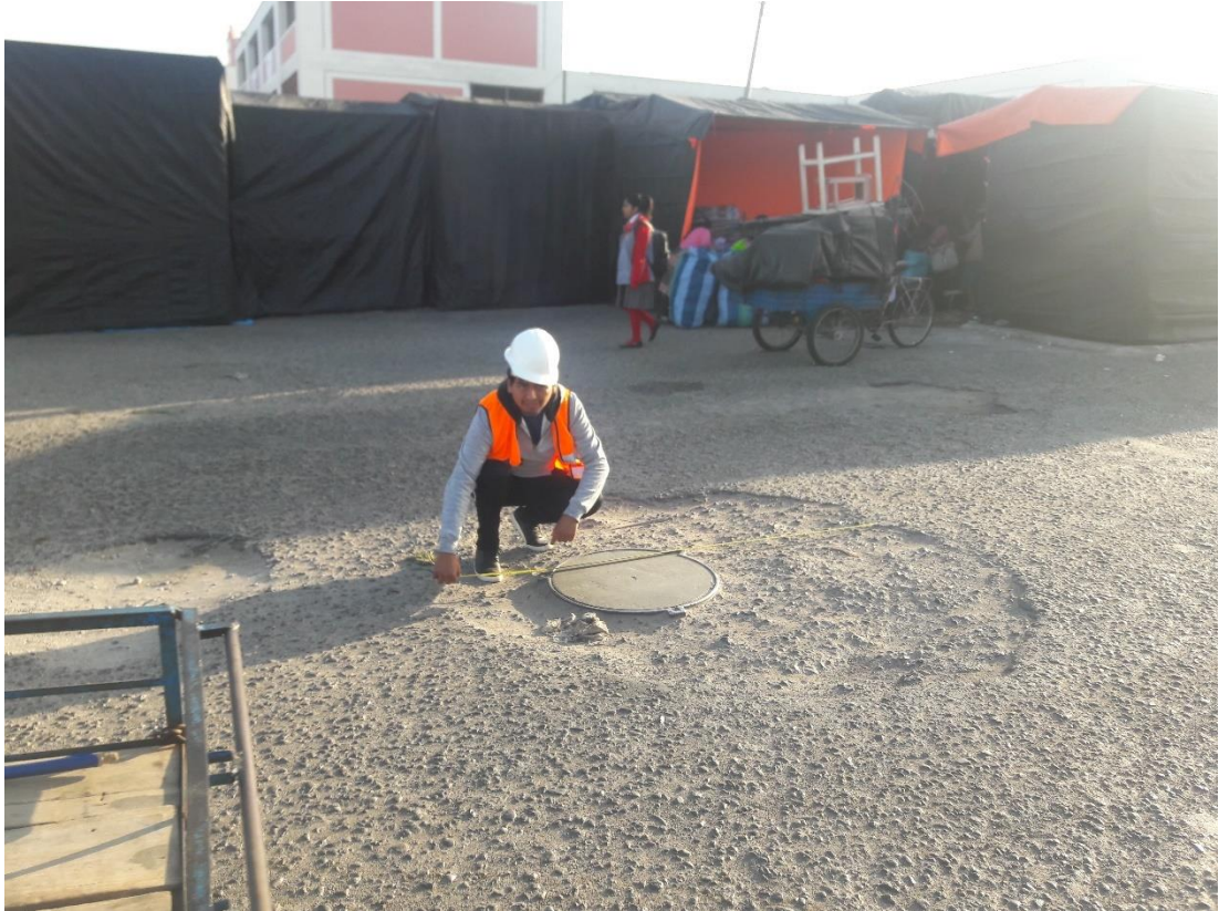
Fotografía 21. Medición del área para el Parcheo del buzón al frente del Instituto Tecnológico Vigil.
