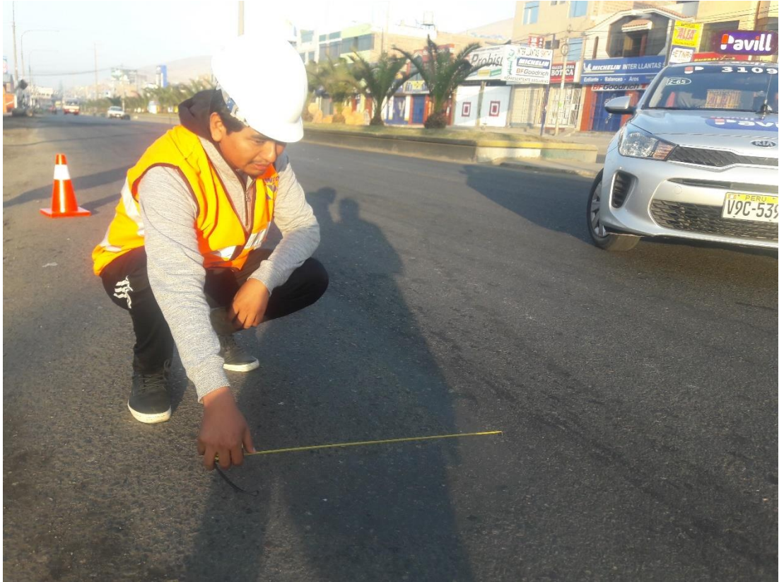
Fotografía 5. Obtención del área para el tipo de falla de Depresión para el PCI.
