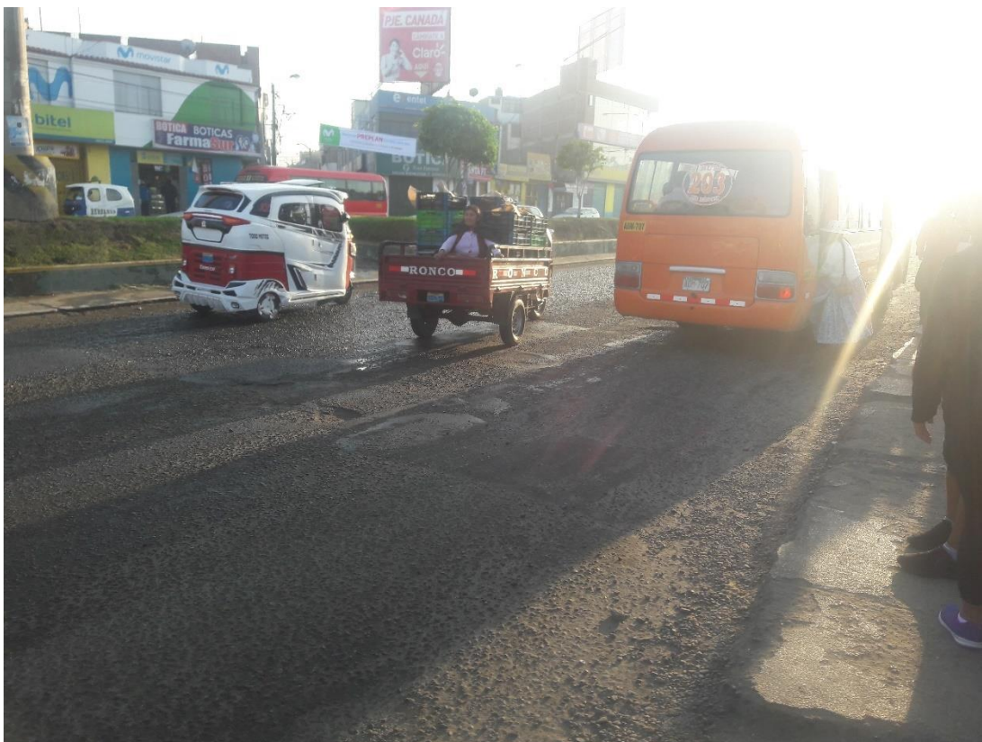
Fotografía 7. Tránsito vehicular a la altura de la intersección con la avenida Tarata, nótese el mal estado de la vía (Desgaste de la superficie y parcheos).
