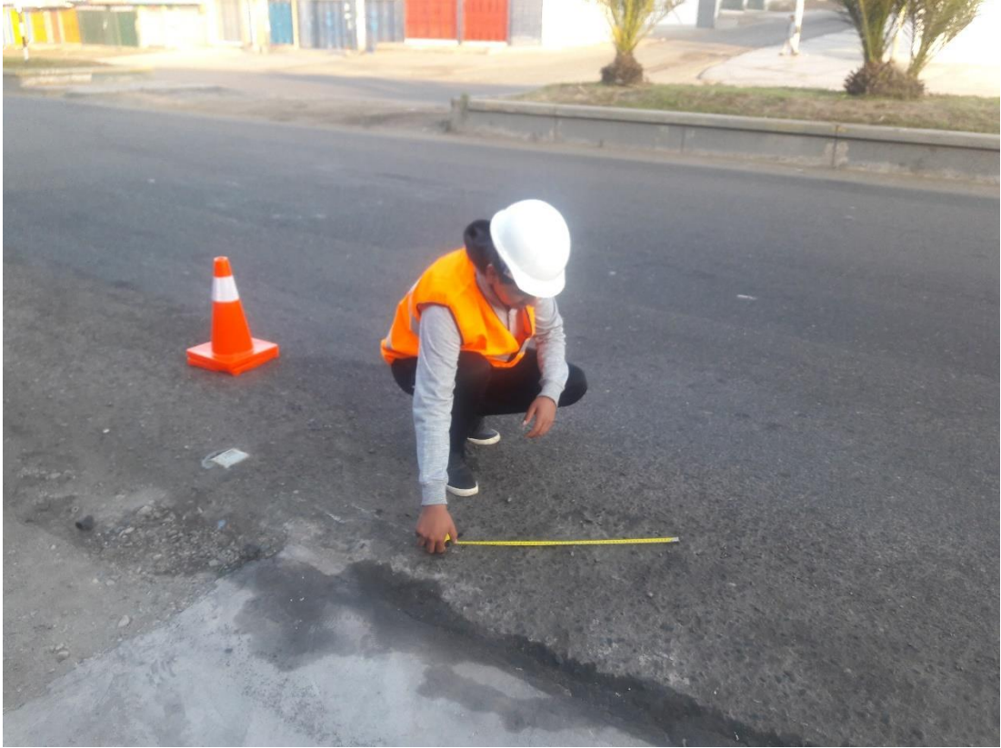
Fotografía 3. Obtención del área para el tipo de falla de Huevo para el PCI.
