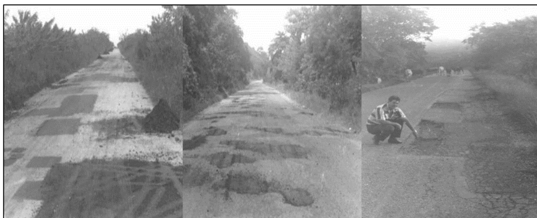
Fig. 03-11 Parcheo de baja, media y alta severidad.
