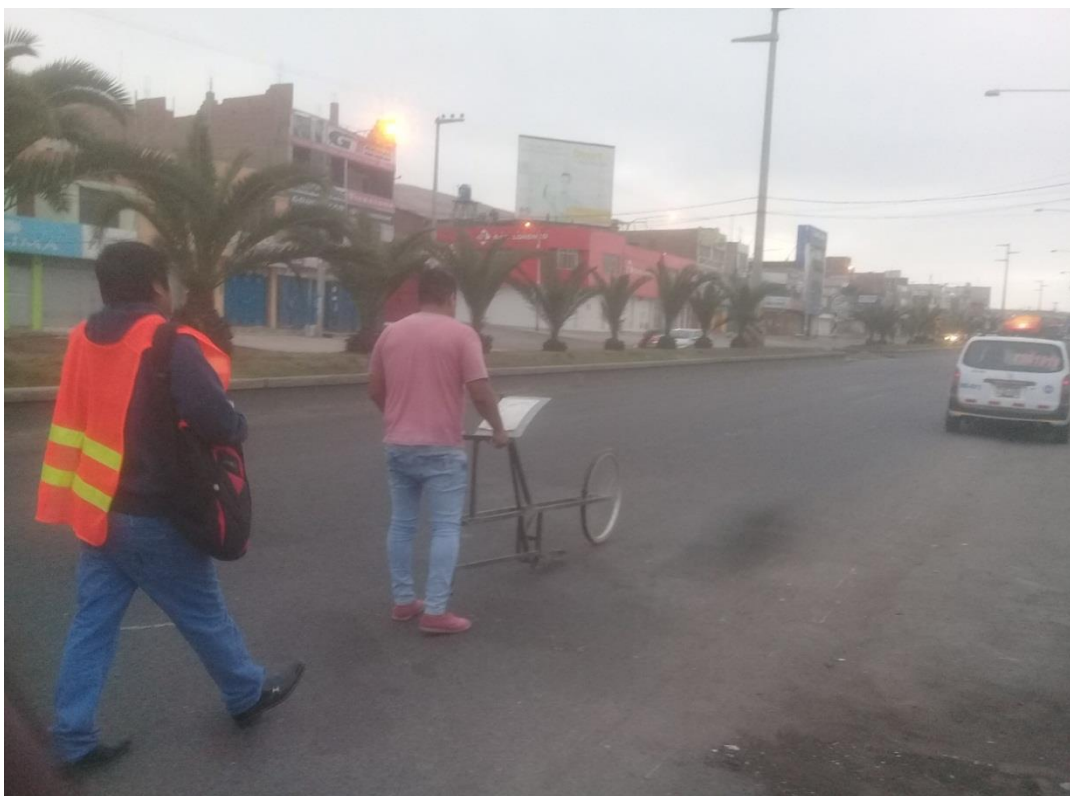
Fotografía 30. Se observa el uso del chaleco de seguridad como protección al tráfico además de que se contaba con apoyo adicional que recurrentemente se encargaba de vigilar la velocidad con que transitaban los vehículos.
