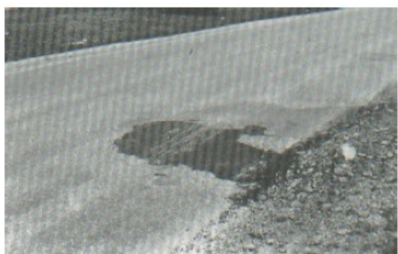
Figura 11-b: Parcheo y acometidas de servicios públicos (Severidad media)
