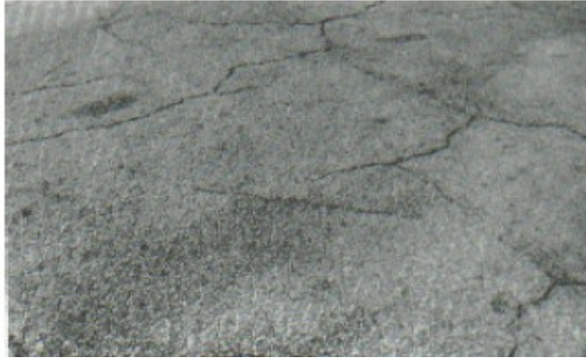
Figura 3-a : Grietas en bloque (Severidad baja)
