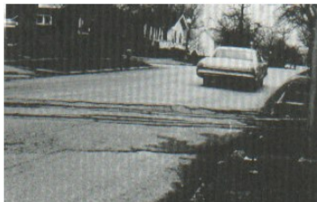
Figura 14-c: Cruce de vía férrea (Severidad alta)
