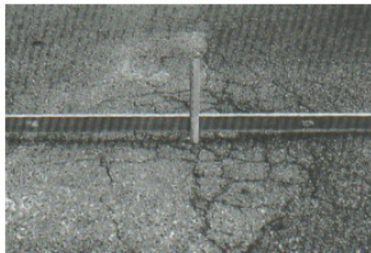
Figura 6-b : Depresión (Severidad media)
