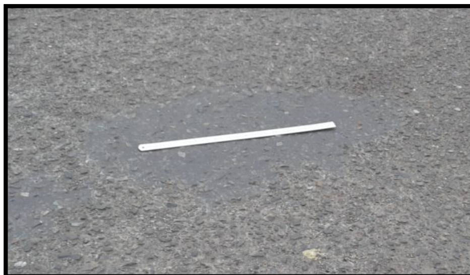
Exudación de Severidad Baja
