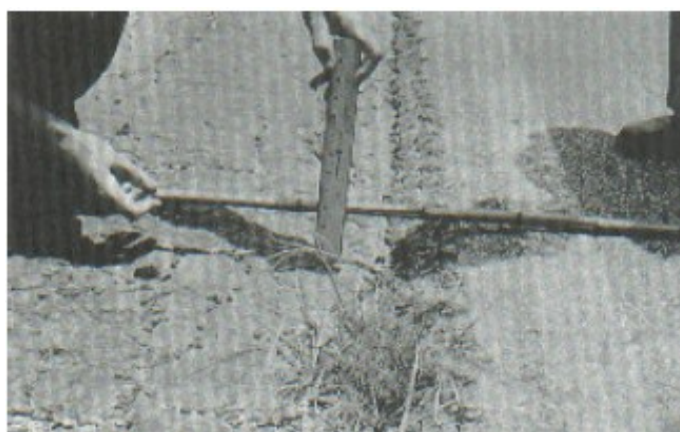
Figura 9-b : Desnivel carril (Severidad media)
