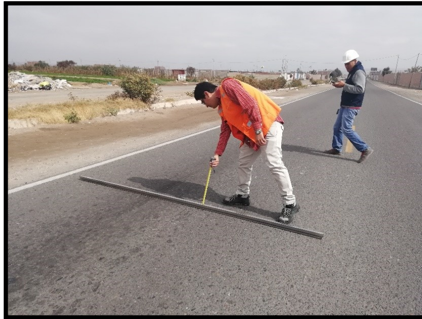
Toma de Medidas de Ahuellamiento
