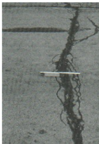
Figura 8-c : Grieta de reflexión de junta (Severidad alta)
