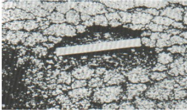
Figura 13-a: Hueco (Severidad baja)
