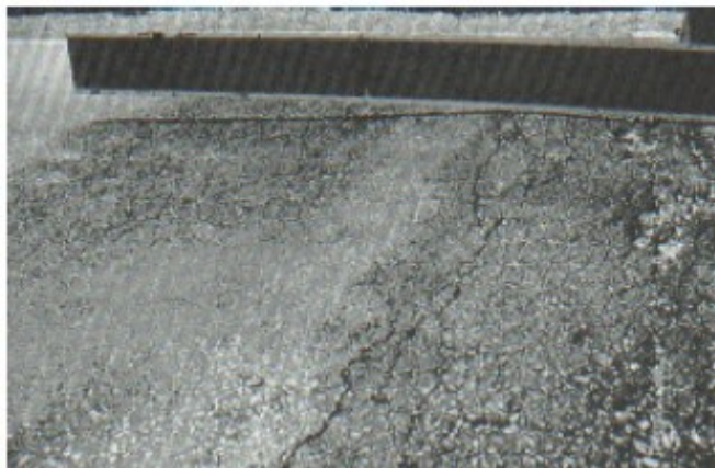
Figura 4-c : Abultamientos y hundimientos (Severidad alta)
