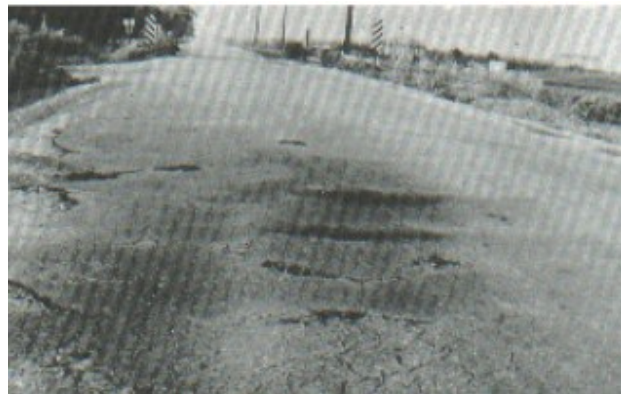
Figura 16-b: Desplazamiento (Severidad media)
