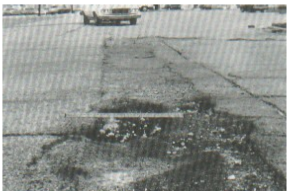
Figura 11-c: Parcheo y acometidas de servicios públicos (Severidad alta)
