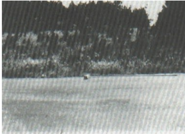
Figura 18-a: Hinchamiento. El nivel de severidad se basa en el criterio de la calidad de tránsito
