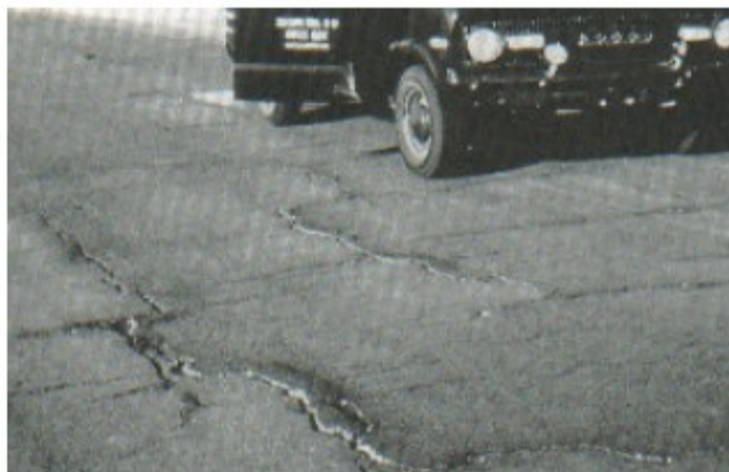
Figura 3-c : Grietas en bloque (Severidad alta)
