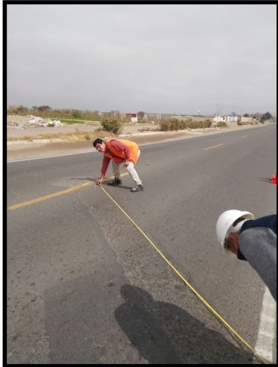
Medición de la Falla del Hundimiento
