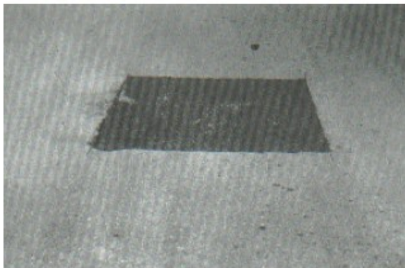
Figura 11-a: Parcheo y acometidas de servicios públicos (Severidad baja)
