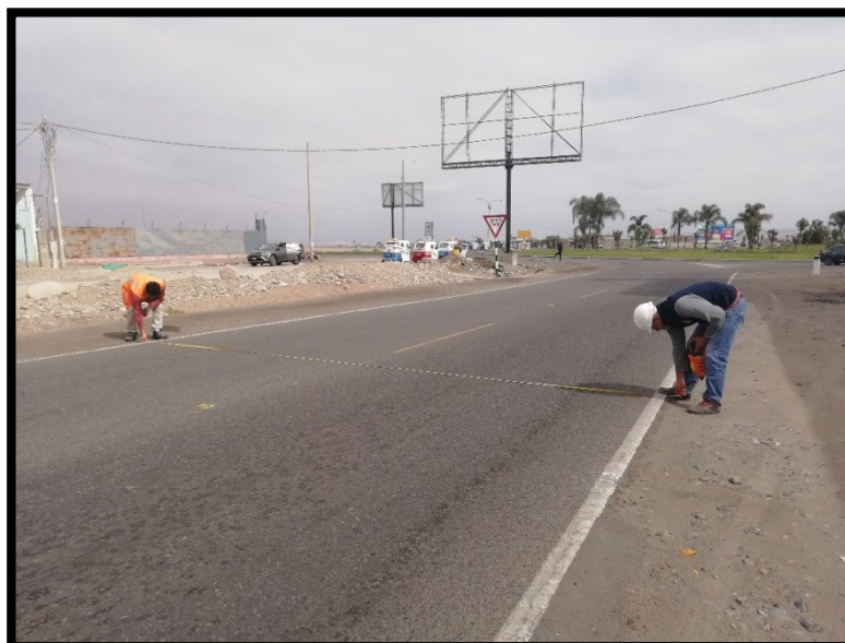
Toma de Medición del ancho de la vía
