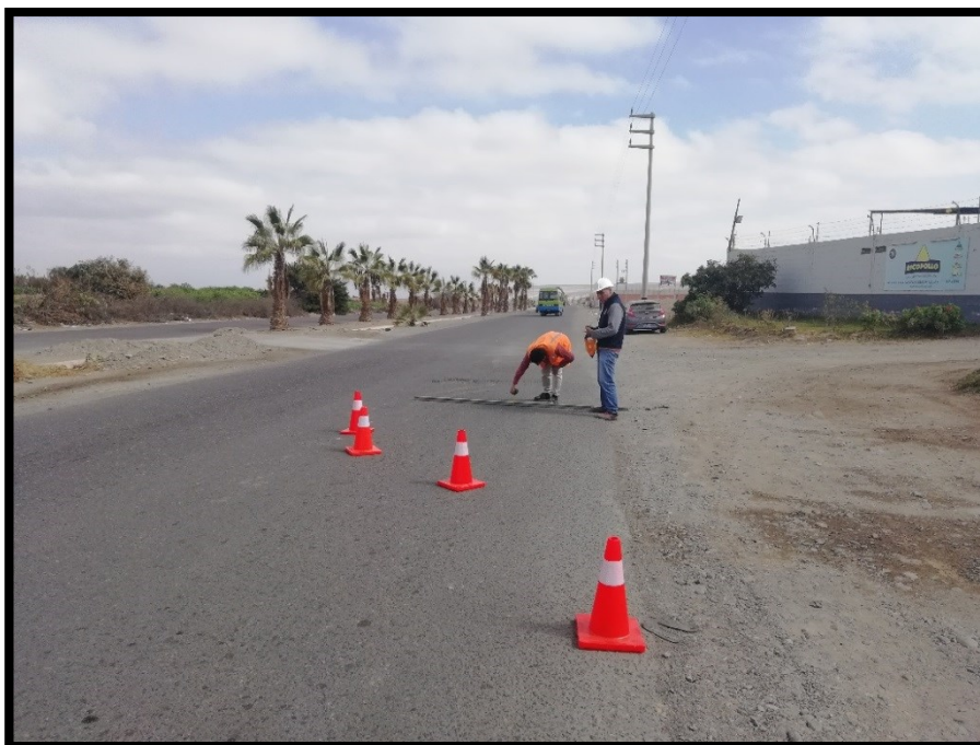
Medición de la Falla de Fisura Longitudinal
