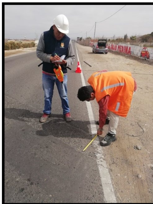
Medición de un Parche de Severidad Media
