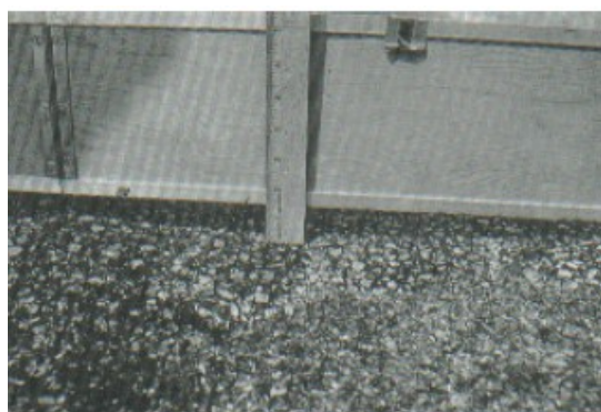
Figura 15-c: Ahuellamiento (Severidad alta)
