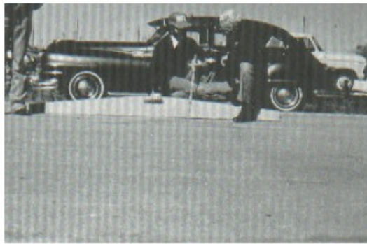
Figura 6-a : Depresión (Severidad baja)
