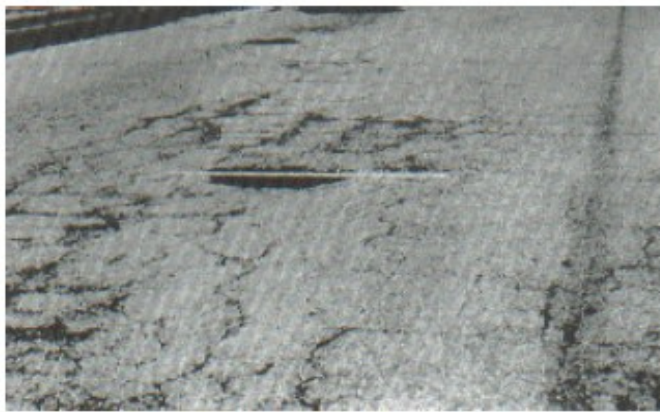
Figura 13-b: Hueco (Severidad media)
