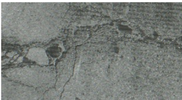
Figura 10-b : Grietas longitudinales y transversales (Severidad alta)
