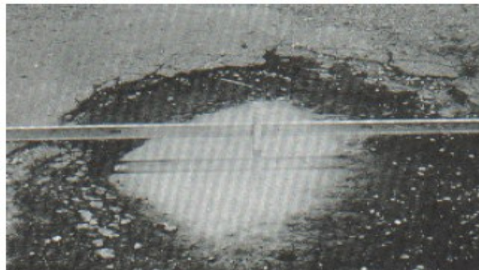
Figura 13-c: Hueco (Severidad alta)
