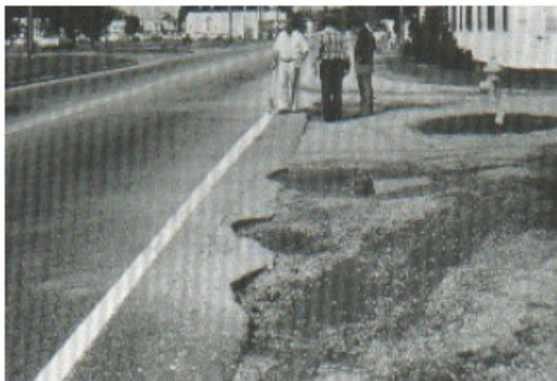
Figura 7-c : Grieta de borde (Severidad alta)
