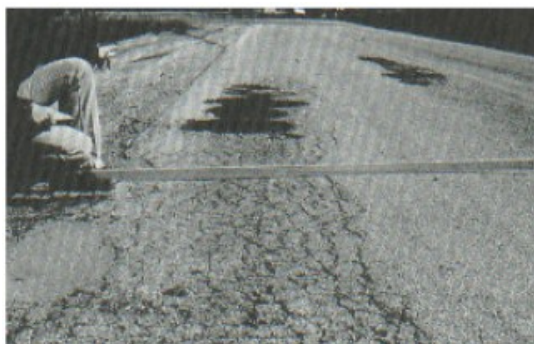
Figura 1-c : Piel de cocodrilo (Severidad alta)
