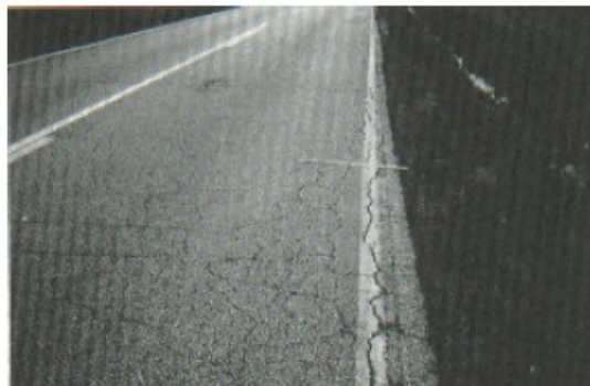
Figura 1-b : Piel de cocodrilo (Severidad media)
