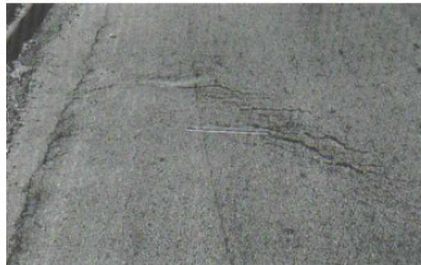
Figura 17-b: Grieta parabólica - slippage (Severidad media)
