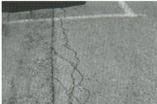
Figura 7-b : Grieta de borde (Severidad media)
