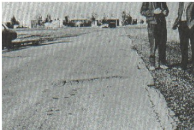
Figura 4-b : Abultamientos y hundimientos (Severidad media)
