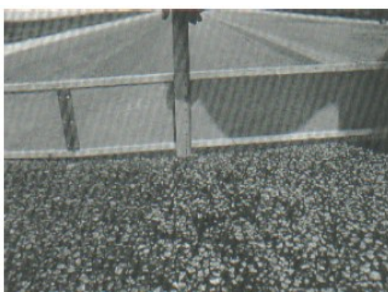
Figura 15-b: Ahuellamiento (Severidad media)
