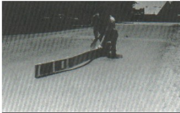
Figura 16-a: Desplazamiento (Severidad baja)
