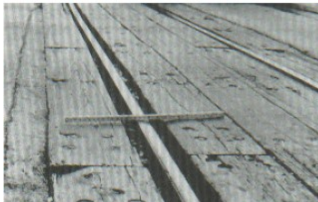
Figura 14-b: Cruce de vía férrea (Severidad media)
