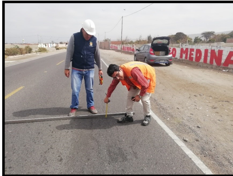
Toma de Medidas de las Fallas Observadas
